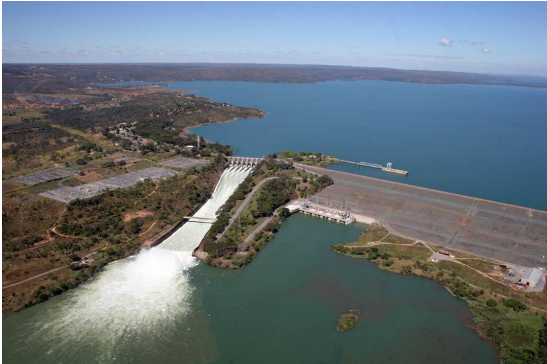
Figura 3.2: Vista para a Usina Hidrelétrica de Três Marias. Fonte: CEMIG.
