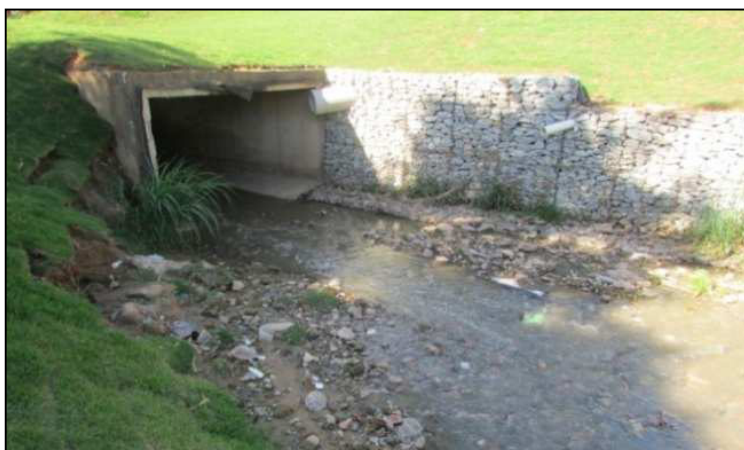
Figura 4.4 – Entrada da galeria de canalização do córrego do Engenho Nogueira em sua porção a céu aberto.
