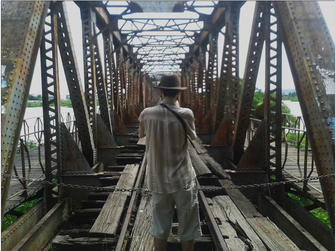
Figura 13 – Ponte Marechal Hermes, sobre o Rio São Francisco. Buritizeiro/Pirapora.
