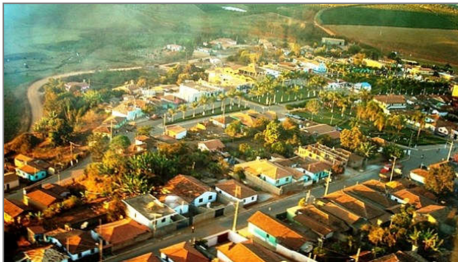
Figura 31: Fotografia da sede municipal de Angelândia FONTE: PREFEITURA DE ANGELÂNDIA (2018).
