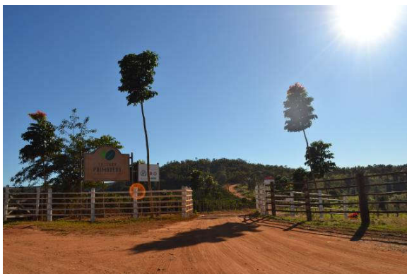
Figura 27: Estrada de acesso à Fazenda Primavera Foto: Pedro Cardoso (agosto/2015)
