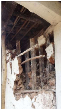
Figura 189: Parede de Pau-a-pique FOTO: SILVA (2016)
