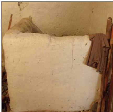
Figura 214: Muro com medida de 9 alqueires (para guardar o coco do café) FOTO: SILVA (2016)
