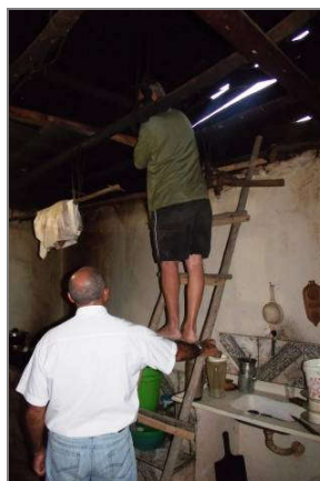
Figura 195: Forró de tábuas utilizado como sótão.
