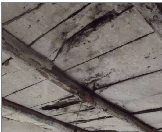
Figura 194: Forro de tábuas justapostas sobre caibros.
