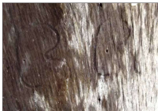
Figura 199: Registro “RR” na porta de entrada.
