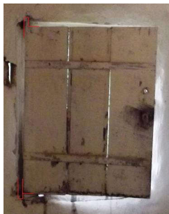
Figura 192: Janela de madeira com dobradiça de encaixe. FOTO: SILVA (2016)
