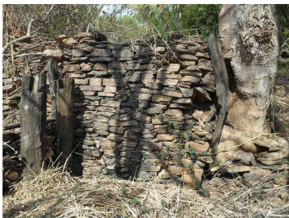
Figura 128: Muro de pedra da gangorra e algumas peças de madeira Foto: Dêga Fernandes
