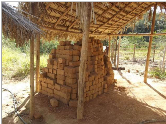
Figura 260: Tijolos de adobe produzidos no quintal do Casarão
