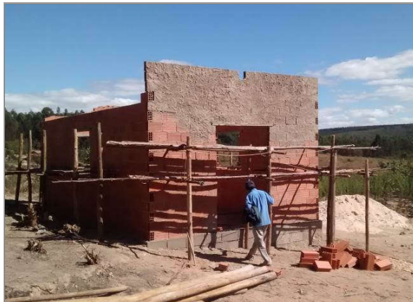
Figura 308: Igreja em construção – Córrego do Algodão FOTOS: SILVA (2015)
