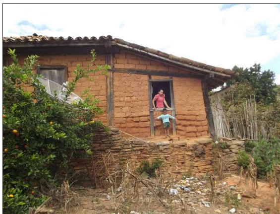
Figura 190: Parede de Adobe e embasamento em pedra seca. FOTO: NASCIMENTO (2015)
