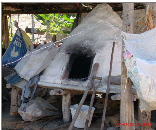
Figura 276: Forno de Barro pontudo. Foto: SILVA (2018)
