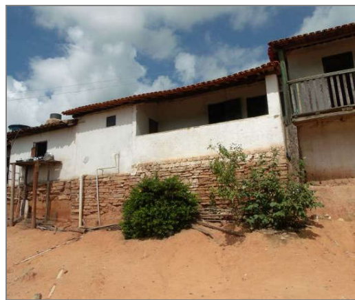
Figura 287: Embasamento estrutural de pedra seca do Solar de D. Nôra
