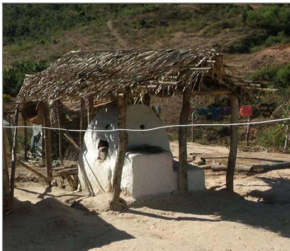
Figura 265: Forno de Biscoito sobre cobertura de palha do Coqueiro Catolé (Alto dos Bois) FOTO: SILVA (2015)
