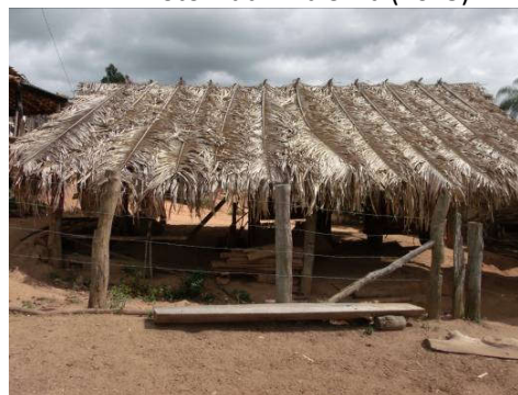
Figura 39: Uso da palha para cobertura de uma tenda de beneficiamento de produtos alimentícios (cana, mandioca, coquinho Catolé, etc.) Foto: Ludimila Silva (2015)
