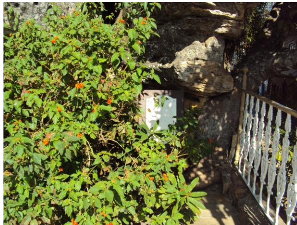
Figura 14: Placa explicativa encoberta pela vegetação na entrada da Gruta de São Thomé evidenciando falta de manutenção
