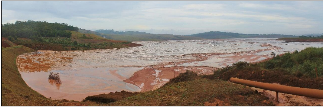
Figura 18: Foto "H", vista parcial da barragem de rejeito da Mina do Pico na região central do Sinclinal Moeda, representando outro aspecto da classe "Área de mineração".
