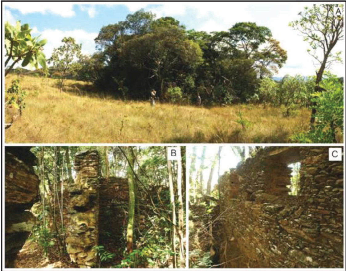
Figura 76 - Sítio Casa Forte - elementos da geodiversidade. A - Capão de mato onde se localiza a ruína. B e C - Detalhes das paredes da ruína.
