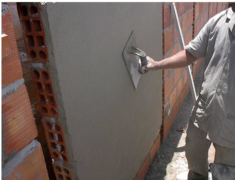
Figura 4.7 – Desempenamento com desempenadeira de madeira.
