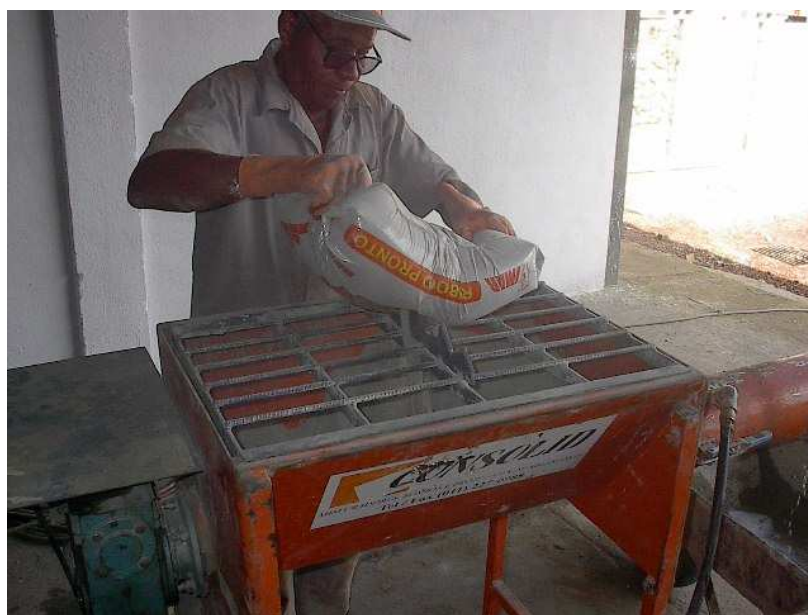
Figura 4.4 – Mistura da argamassa industrializada na argamassadeira.
