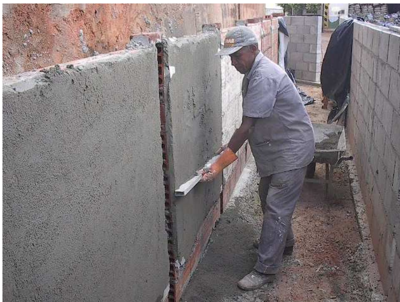
Figura 4.6 – Operário sarrafeando a argamassa.
