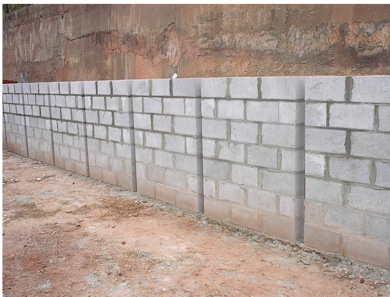
Figura 4.3 – Painéis teste em bloco de concreto.
