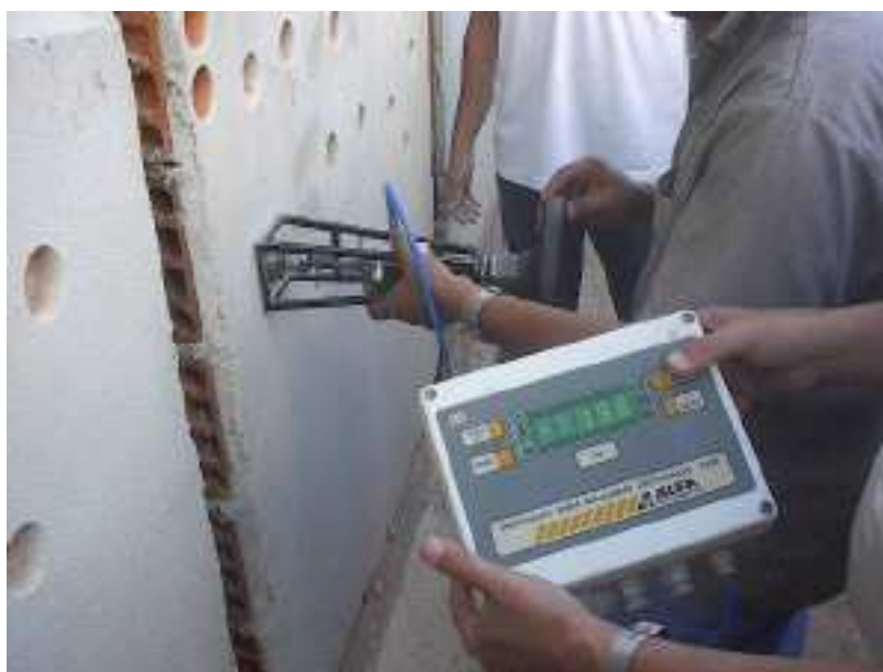
Figura 4.9 – Realização de teste de resistência de aderência com equipamento digital.
