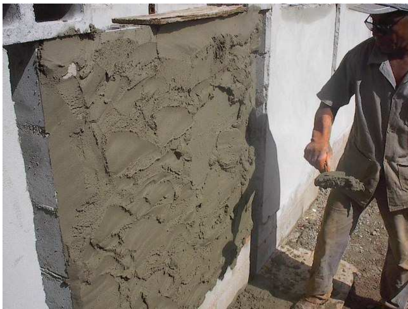
Figura 4.5 – Aplicação da argamassa sobre painel de alvenaria.
