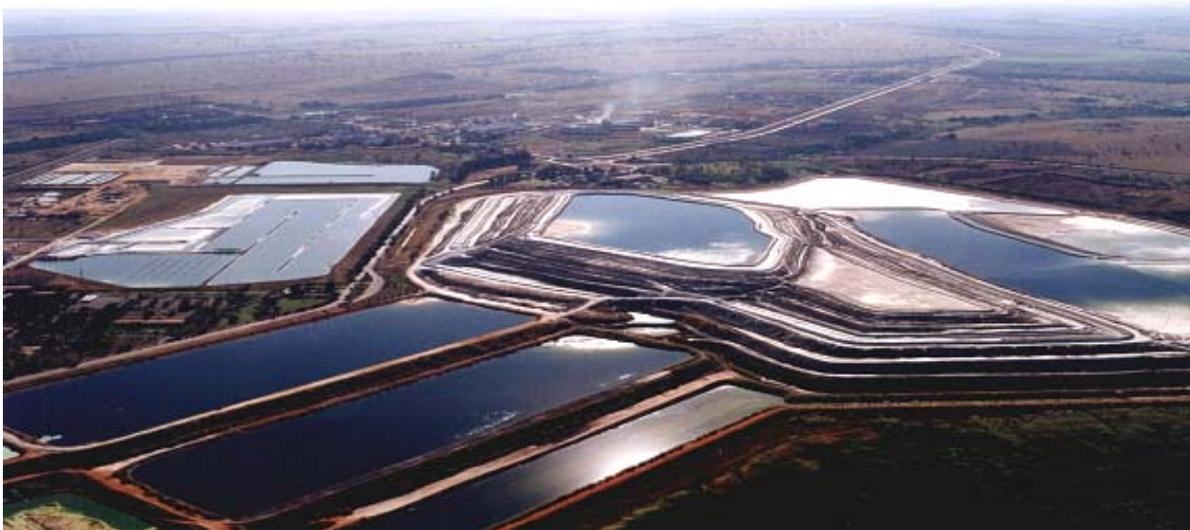
Figura 4.10 - Armazenamento do fosfogesso.
