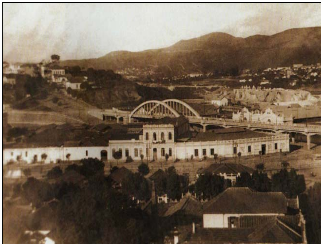
Figura 6.2: Viaduto Santa Tereza
