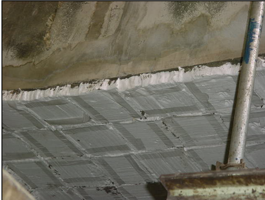
Figura 5.3: Aplicação de revestimento para proteção do concreto contra altas temperaturas
