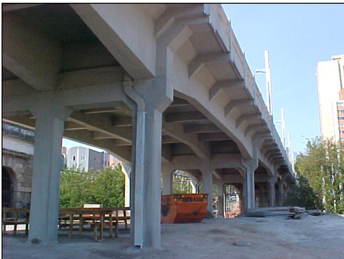
Figura 6.3: Viaduto da Floresta após recuperação em 2001
