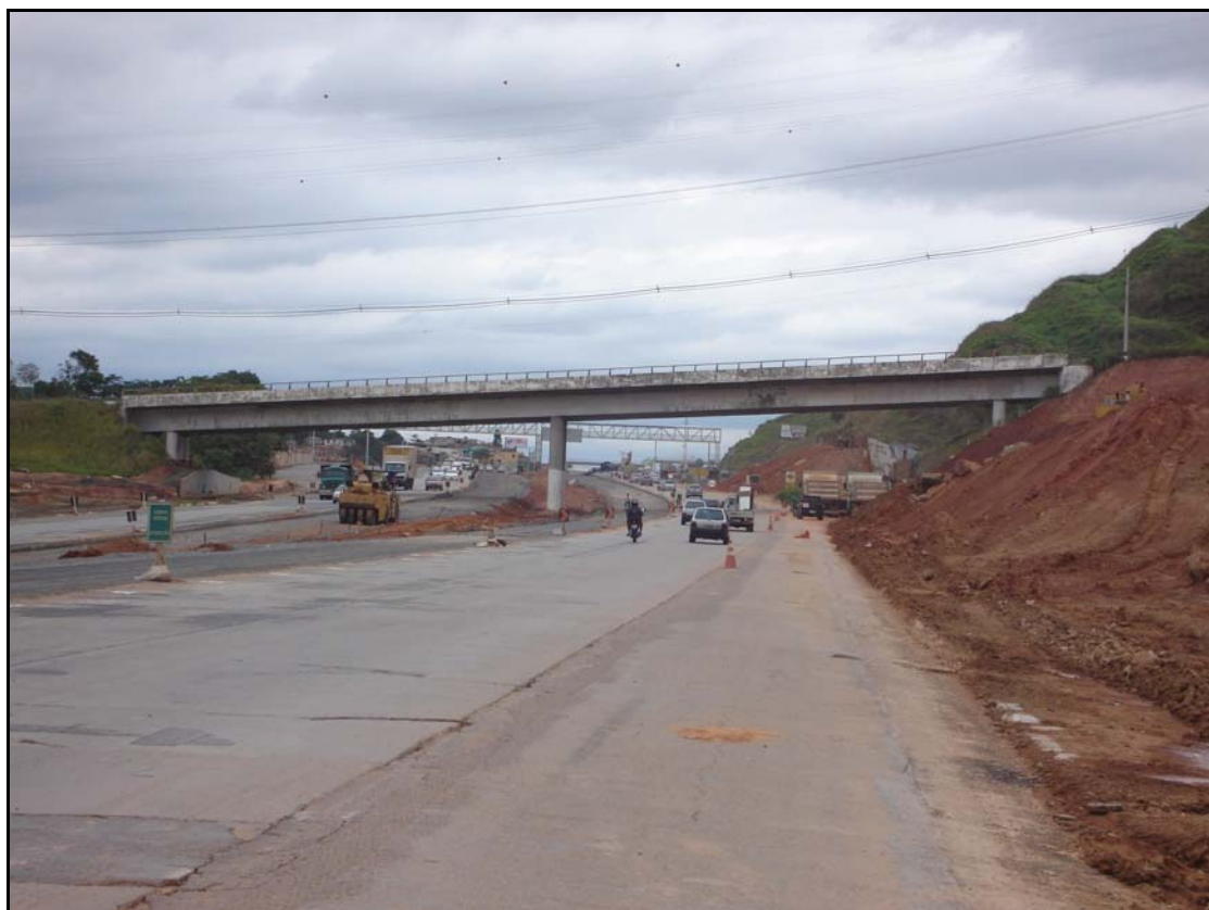
Figura 6.9: Vista lateral do viaduto de acesso a São Benedito na Linha Verde
