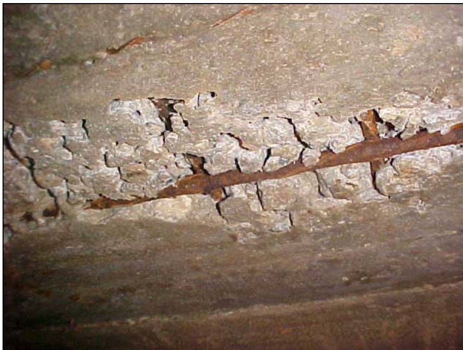
Figura 5.5: Falta de estanqueidade nas fôrmas causou fuga de argamassa
