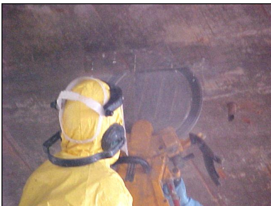
Figura 5.2: Dificuldade de abertura de uma janela para inspeção quando não foi prevista em projeto
