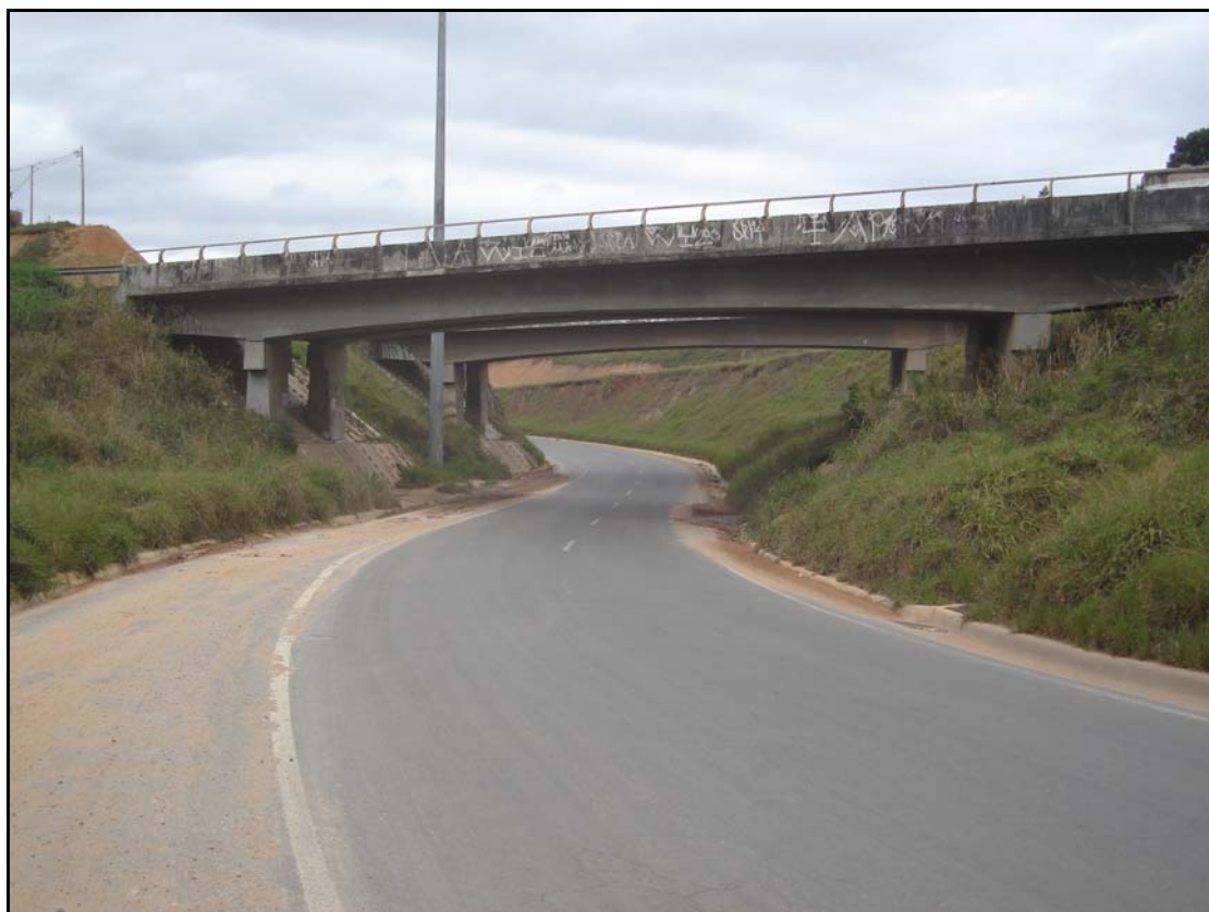
Figura 6.8: Vista lateral do viaduto de acesso a Lagoa Santa na Linha Verde
