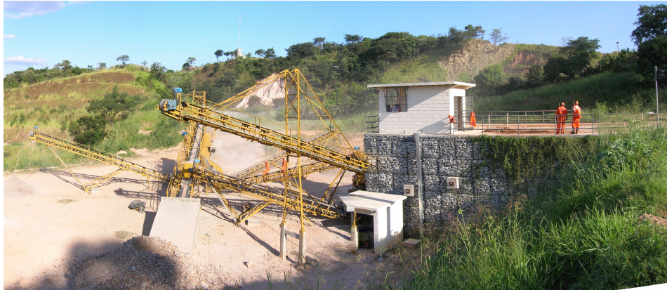
Figura 2.2: Central de reciclagem do Aterro (Belo Horizonte-MG).
