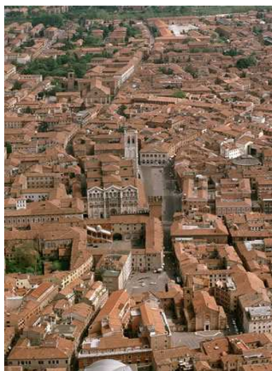
FIGURA 2.1 - Cidade medieval de Ferrara, Itália. Espaço urbano conturbado e edificações de elevado risco em situações de incêndio.
