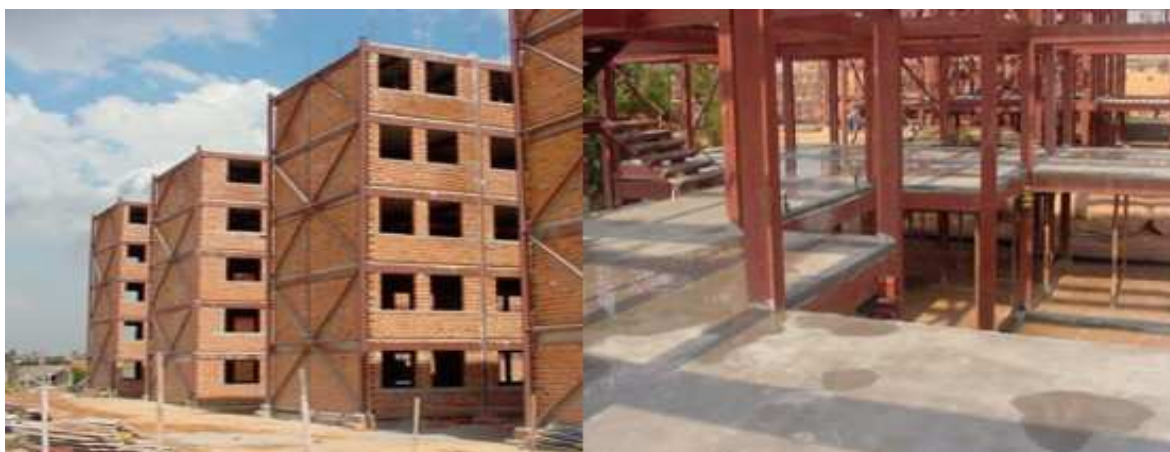
FIGURA 5.9 – Estrutura metálica, vedação e laje, nos edifícios de cinco pavimentos.
