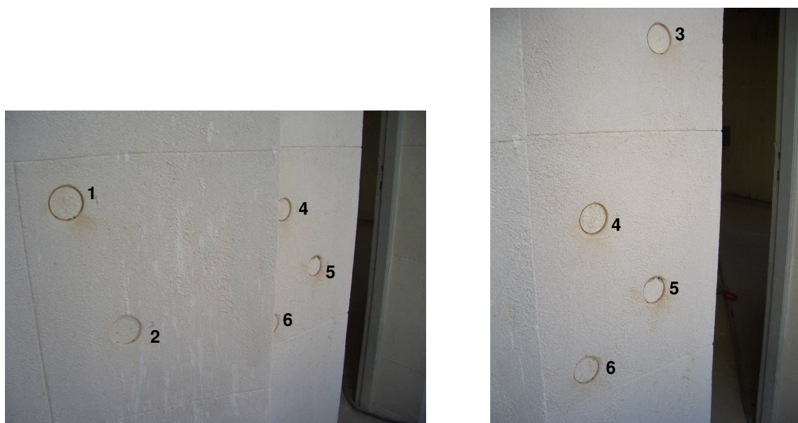
Figura 96 – Locais do ensaio de resistência de aderência à tração.
