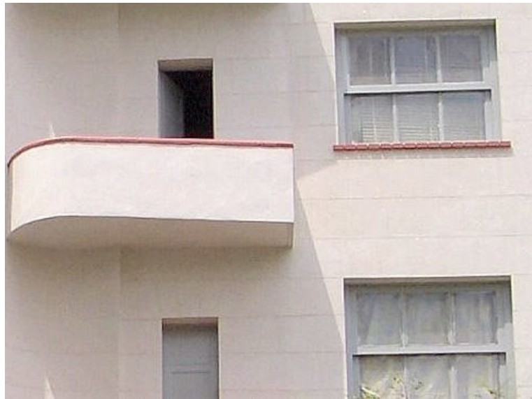
Figura 61 – Detalhe da varanda depois da obra.
