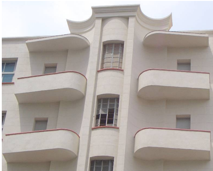
Figura 65 – Detalhe da parte superior do prédio depois da restauração.
