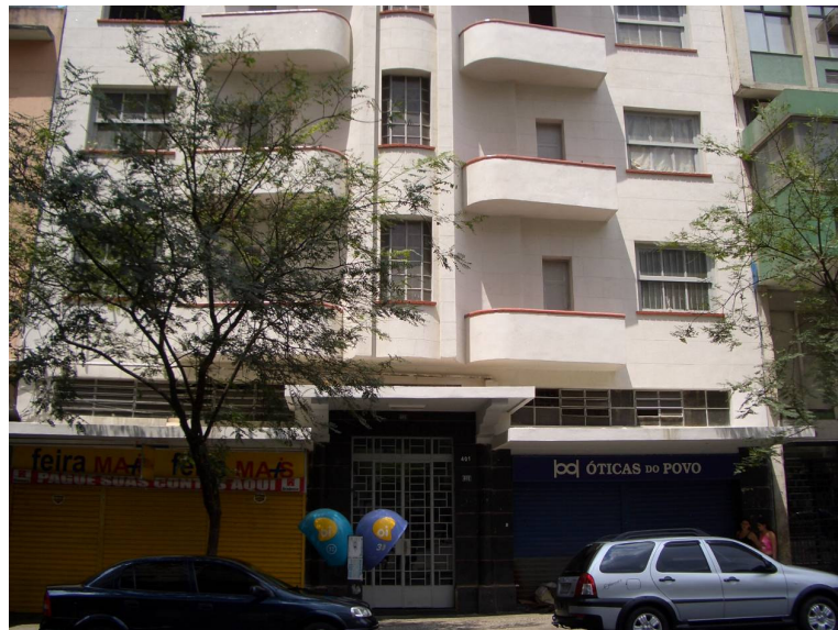
Figura 59 – Vista da entrada do prédio depois do restauro.
