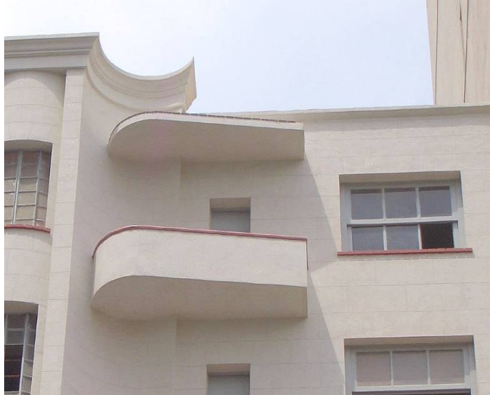
Figura 73 – Vista externa da varanda do 6º andar já com o novo revestimento em pó-de-pedra.
