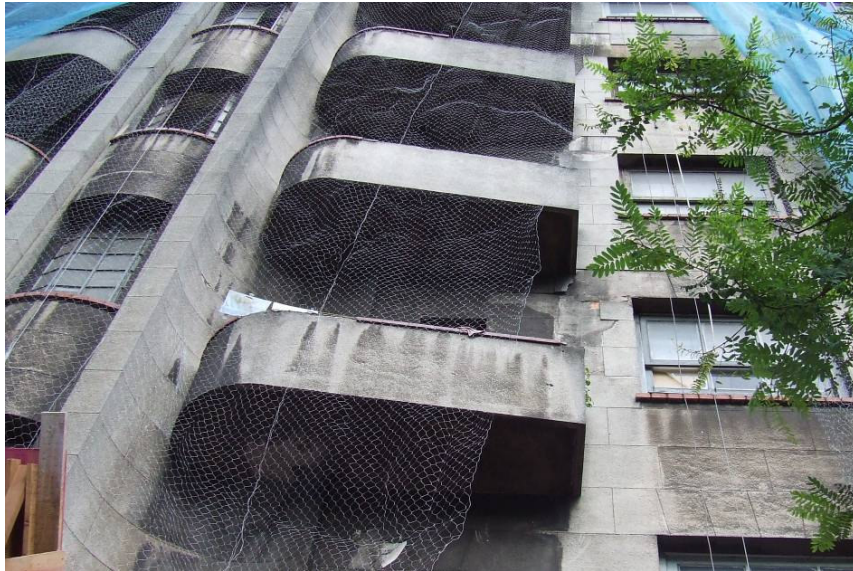
Figura 56 – Varandas com a argamassa em pó-de-pedra original.
