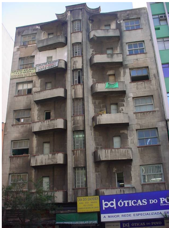
Figura 26 – Fachada do Ed. Thibau antes da restauração.
