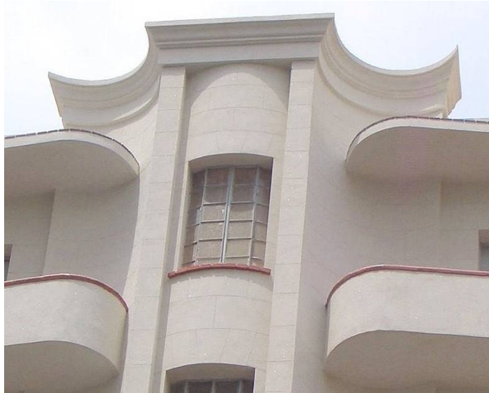
Figura 66 – Detalhe do acabamento no topo do prédio após a obra.
