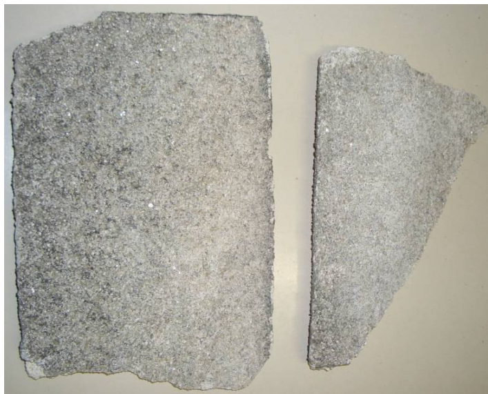
Figura 29 – Duas amostras do revestimento de pó-de-pedra original da fachada.
