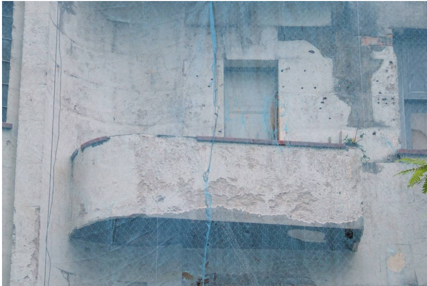
Figura 45 – Trecho da fachada já sem o revestimento antigo.
