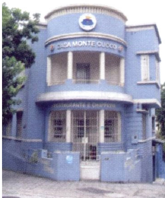
Figura 14 – Casa na Av. Álvares Cabral, 510 - Centro. Fonte: CASTRO, 2006.
