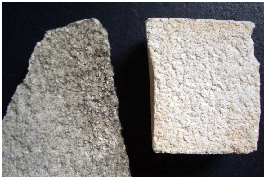
Figura 40 – Amostra do revestimento antigo (esquerda) e amostra do revestimento novo (direita).
