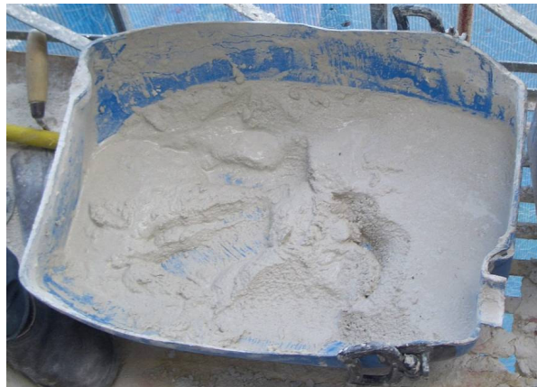
Figura 44 – Mistura final da argamassa de pó-de-pedra.
