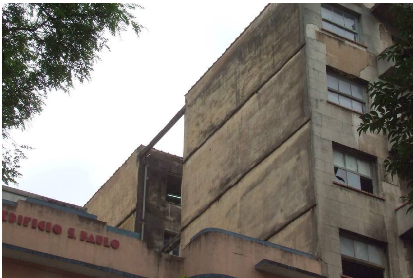
Figura 27 – Detalhe das fachadas lateral e frontal originais. Presença do revestimento de pó-de-pedra somente nesta.
