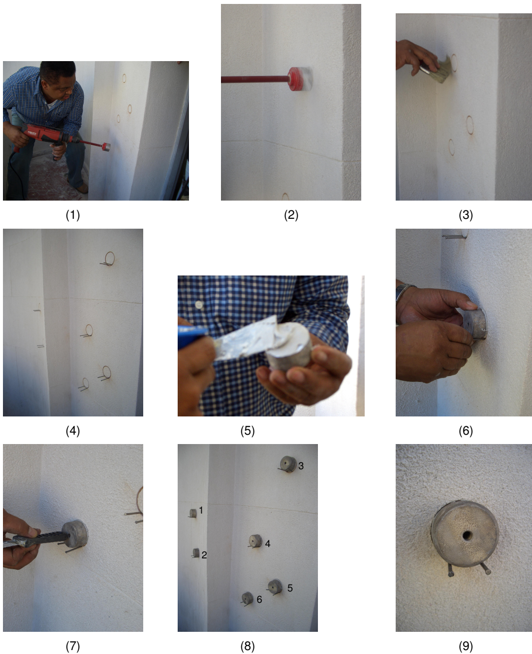
Figura 76 – Seqüência de colagem das pastilhas: (1) e (2) cortes com serra-copo; (3) limpeza das superfícies dos CP's; (4) suportes para auxiliar na sustentação inicial das pastilhas; (5) a cola à base de resina epóxi é passada na pastilha; (6) e (7) colagem das pastilhas; (8) e (9) pastilhas já coladas no revestimento da fachada.
