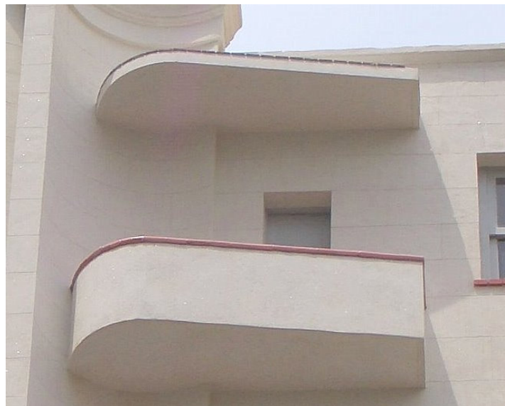
Figura 74 – Vista externa ampliada da varanda do último pavimento.
