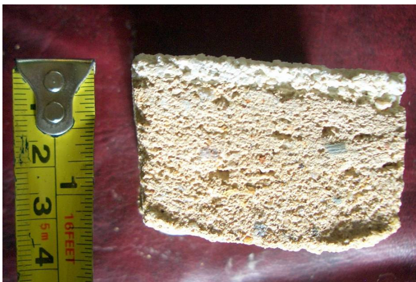
Figura 30 – Amostra de uma espessa camada de emboço (parte inferior) e de uma fina camada de revestimento em pó-de-pedra (parte superior).
