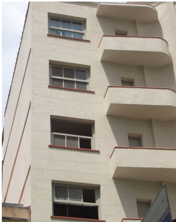
Figura 57 – Varandas com a nova argamassa em pó-de-pedra.
