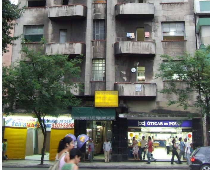
Figura 58 – Vista da entrada do prédio antes do restauro. Fonte: METAMORPHOSE, 2006.
