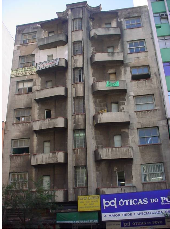
Figura 54 – Vista geral da fachada antes da restauração.
