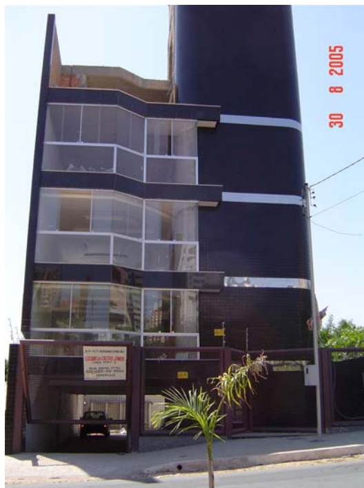
Fotografia 1 – Edifício em cerâmica na cor preta que promove maior absorção de calor, conseqüentemente introduzindo maiores solicitações nas peças cerâmicas.
