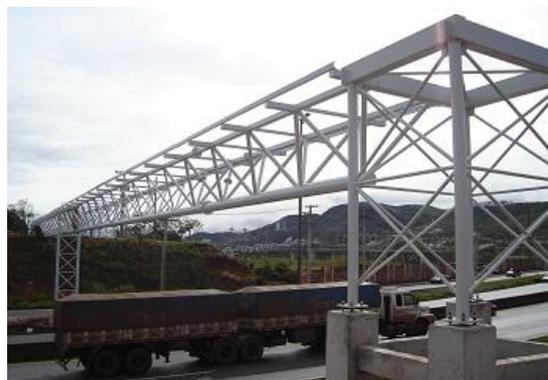
Figura 13 – Aplicação do perfil tubular em passarelas (USIMINAS, 2008).
