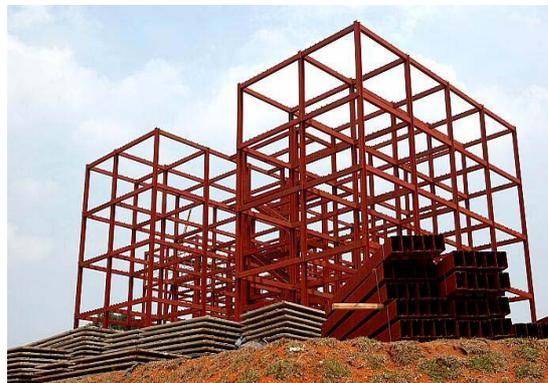
Figura 12 – Aplicação do perfil formado a frio em edifício (USIMINAS, 2008).
