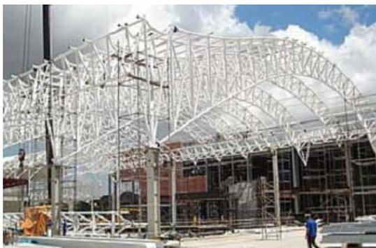
Figura 14 – Aplicação do perfil tubular em coberturas (USIMINAS, 2008).
