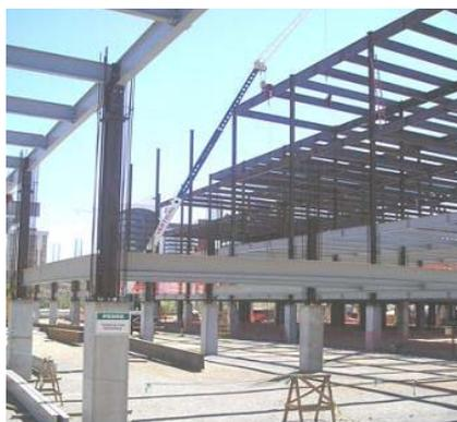
Figura 31 – Pilares mistos revestidos totalmente (USIMINAS, 2008).
