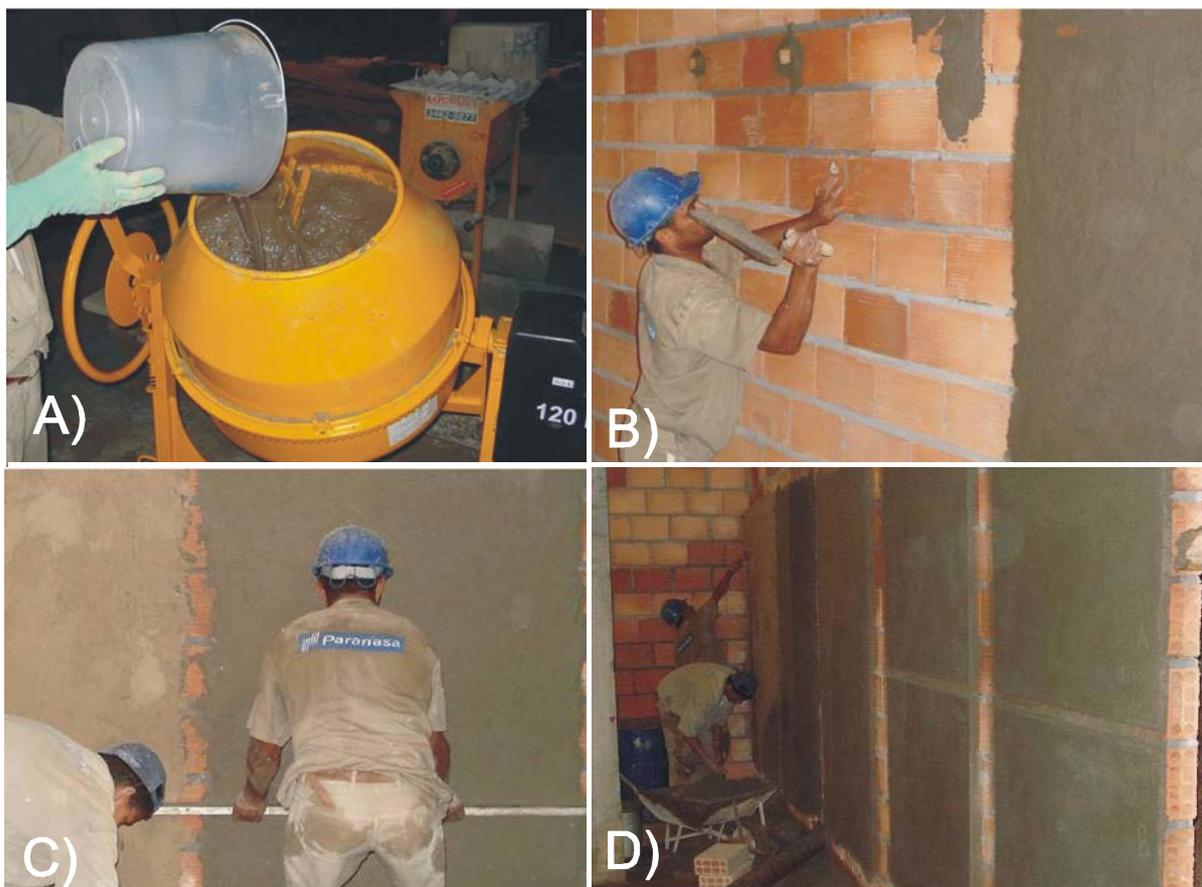
**FIGURA 4-32 – Execução dos Painéis: A) Preparação da argamassa; B) Aplicação da argamassa; C) Sarrafeamento da argamassa; D) Vista dos painéis acabados**
