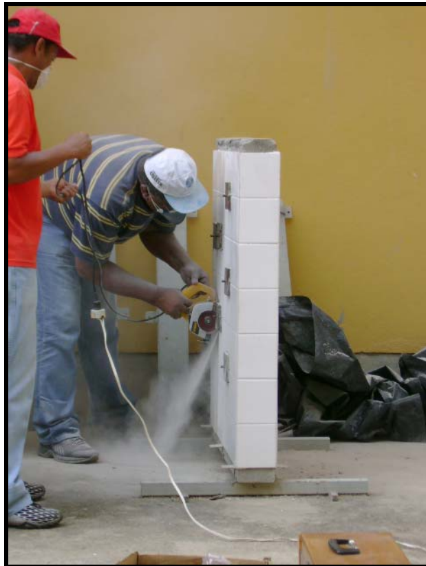
Figura 4.22. – Vista de cortes sendo executados após a colagem das placas.
