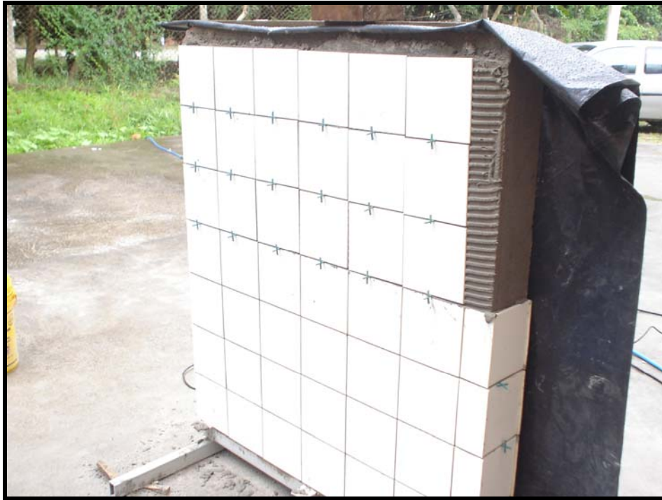
Figura 4.8. – Vista de painel em fase de assentamento de azulejos.
