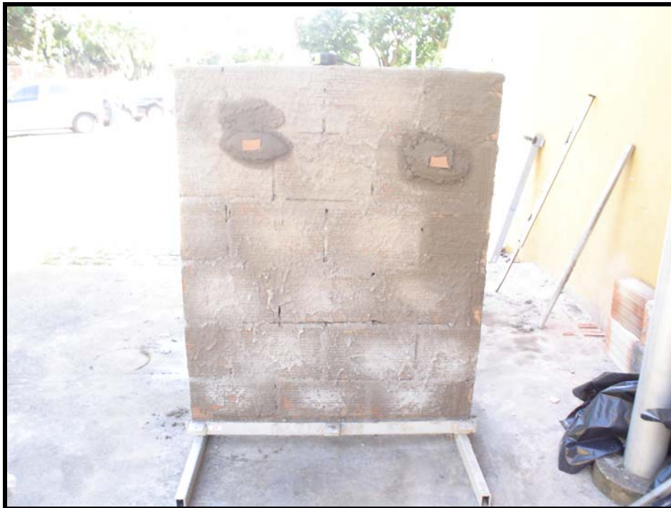
Figura 4.4. – Vista de painel chapiscado e com taliscas de madeira (indicação da espessura do revestimento).
