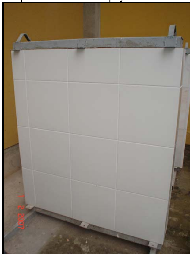
Figura 4.12. – Vista de painel revestido com peças cerâmicas e rejuntado.
