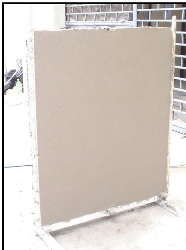
Figura 4.6. – Vista de reboco desempenado e camurçado.
