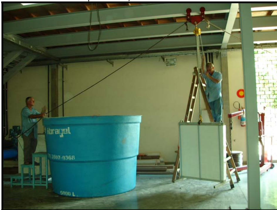
Figura 4.28. – Vista de outro painel em deslocamento vertical para ser introduzido no reservatório.
