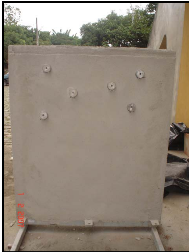
Figura 4.18. – Vista de placas circulares coladas.
