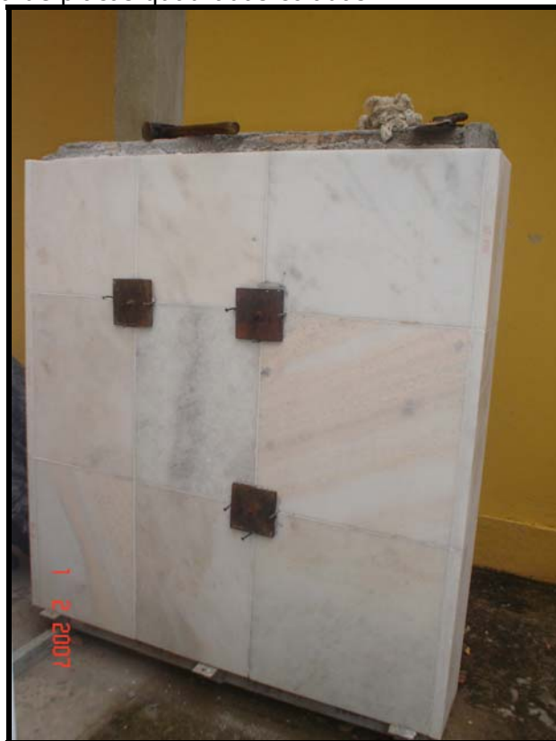
Figura 4.21. – Outra vista de placas quadradas coladas.
