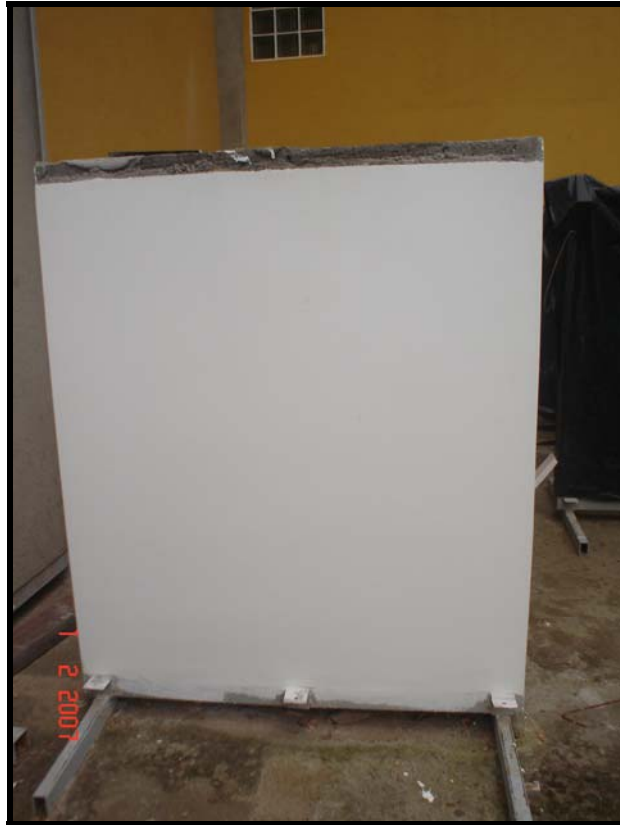
Figura 4.7. – Vista de painel emassado e pintado.
