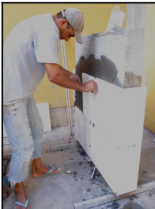
Figura 4.13. – Vista de painel em fase de assentamento de placas de mármore branco.
