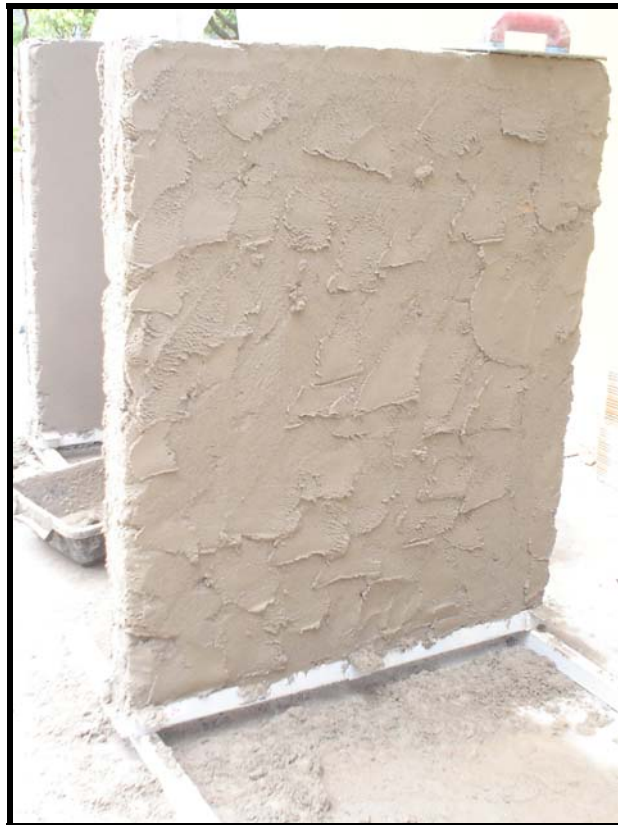
Figura 4.5. – Vista de reboco em execução.
