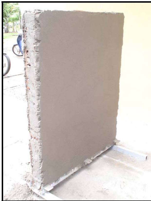
Figura 4.3. - Vista de reboco desempenado e camurçado.
