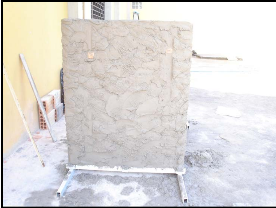
Figura 4.2. - Vista de reboco em execução.
