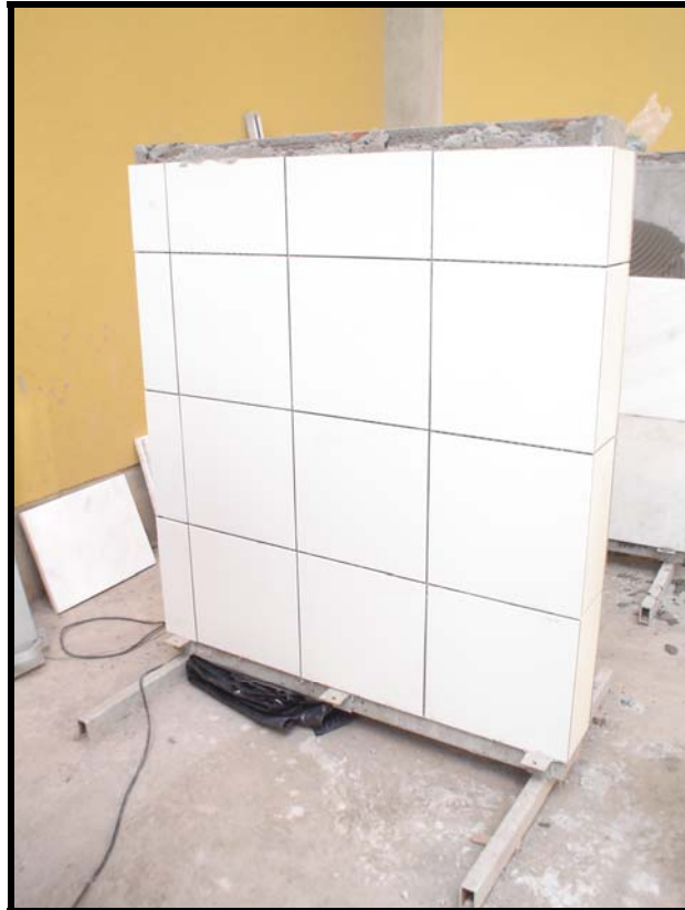
Figura 4.11. – Vista de painel revestido com peças cerâmicas.
