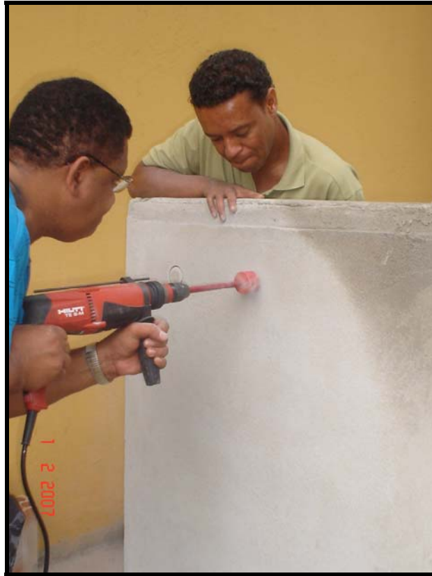
Figura 4.17. – Vista dos cortes sendo executados antes da colagem das placas.
