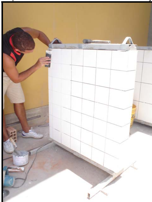
Figura 4.9. – Vista de painel com os azulejos assentados e rejuntamento em fase de execução.
