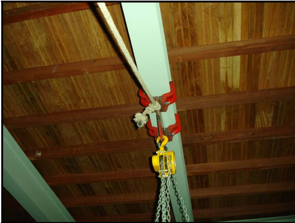
Figura 4.25. – Vista da calha manual acoplada ao dispositivo deslizante.
