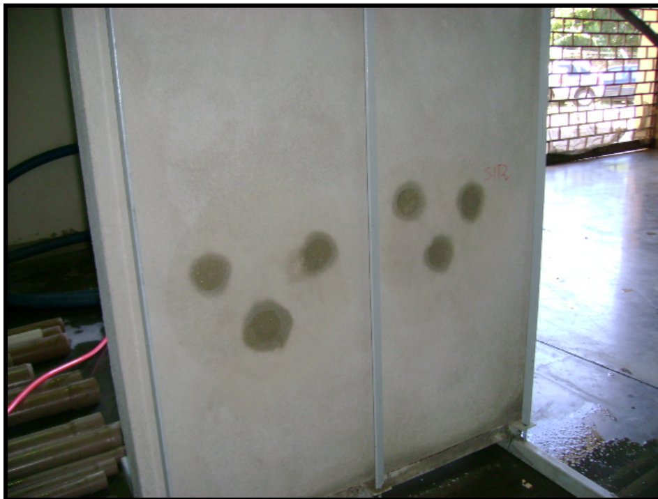
Figura 4.38. – Vista de um painel reconstituído.
