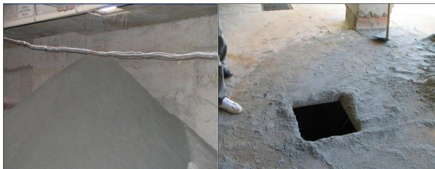
Figura 12 – Sistema de descarga e armazenamento de areia industrial da obra “A”
