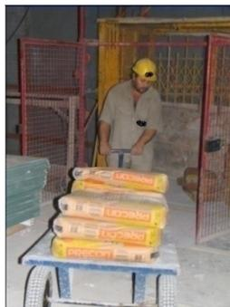
Figura 11 – Transporte horizontal de argamassa industrializada com carrinho plataforma.
