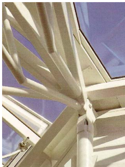
FIGURA 8.9: Detalhes da pintura intumescente em estrutura metálica.
