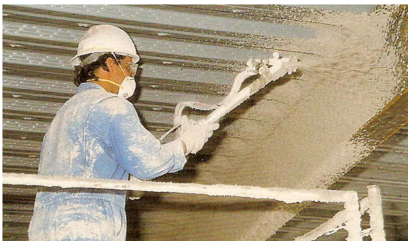
FIGURA 8.3: Fotografia da aplicação da argamassa projetada.
