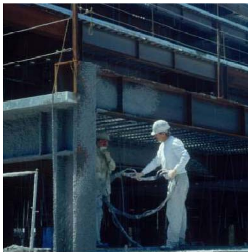
FIGURA 8.6: Argamassa projetada aplicada sobre a estrutura externa de aço.
