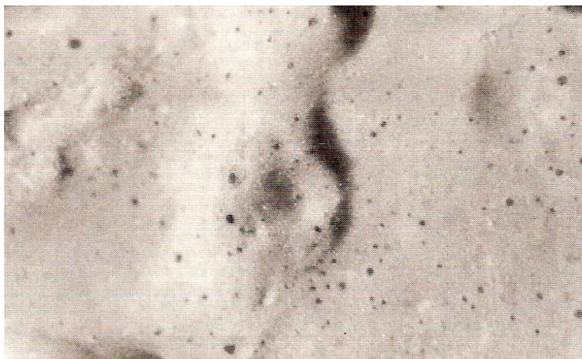
FIGURA 8.4: Fotografia da argamassa projetada com aumento de 10 vezes.
