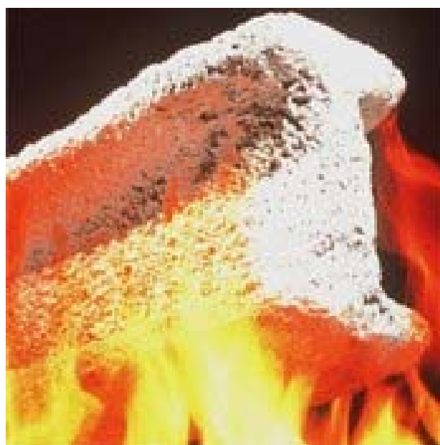
FIGURA 8.5: Argamassa projetada aplicada sobre a estrutura de aço.
