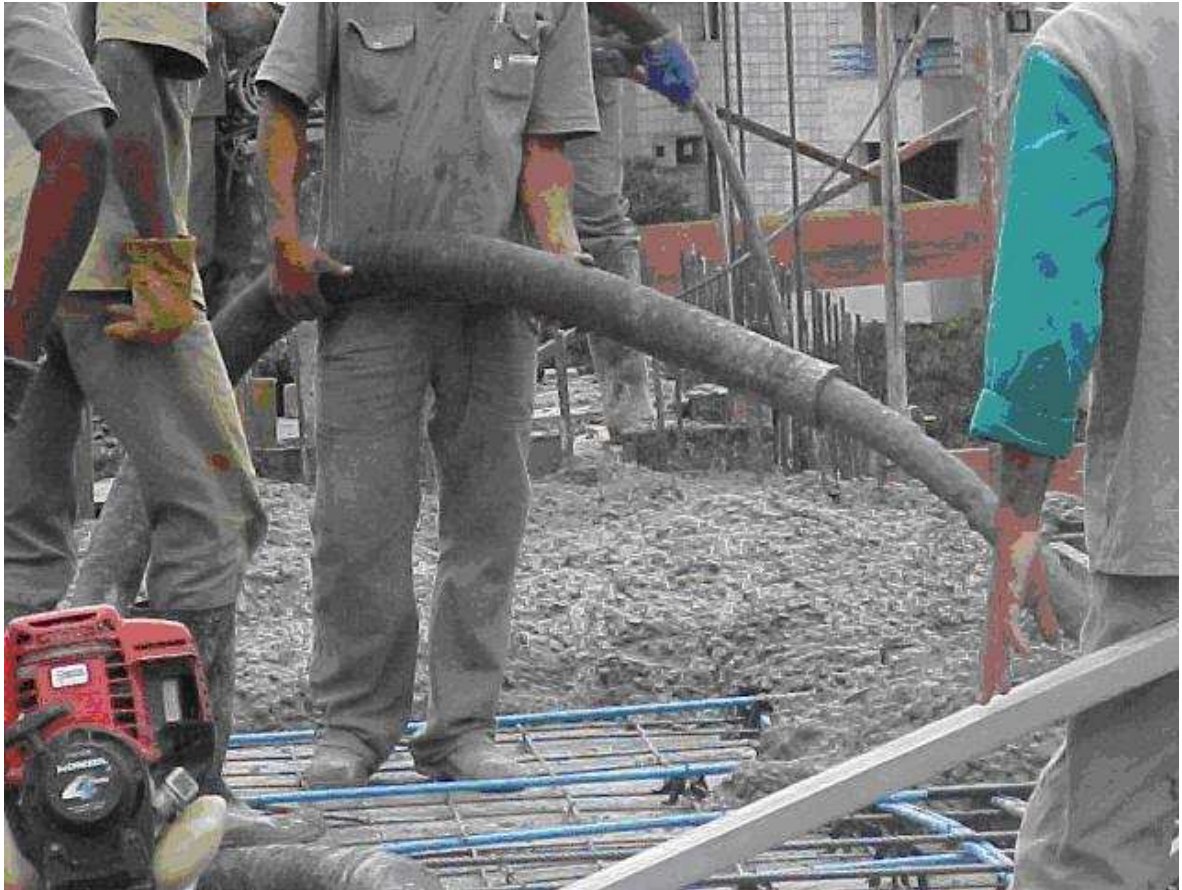
Figura 1.7 – Lançamento do Concreto
