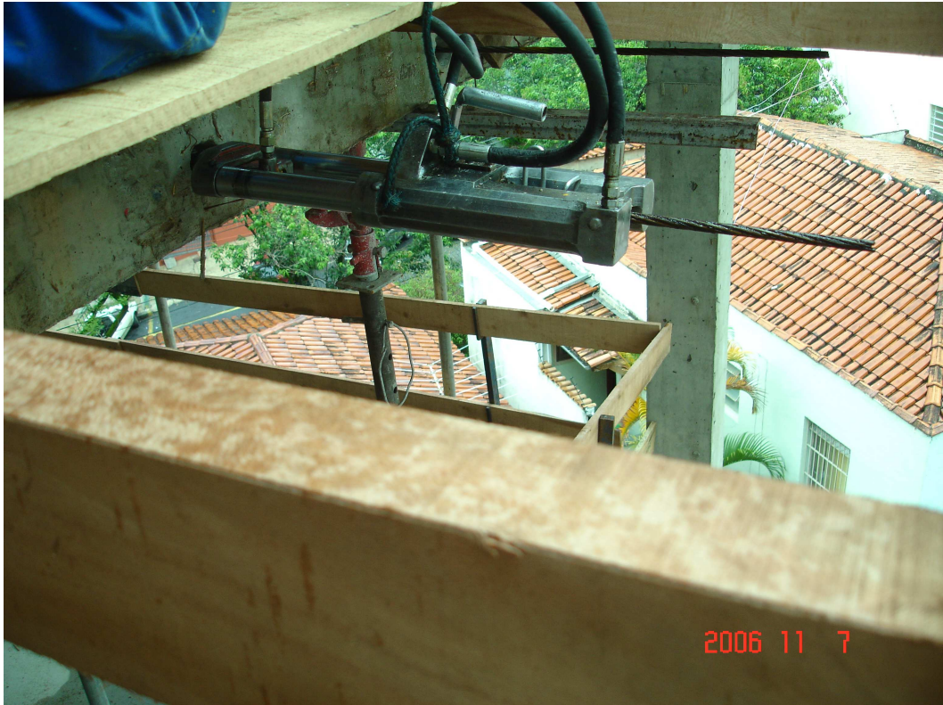
Figura 2.9 – Detalhe do atuador hidráulico para protensão
