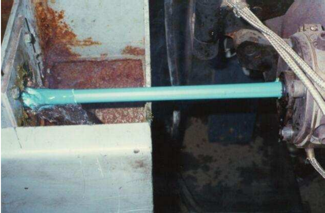
Figura 2.2 – Encapamento da bainha da cordoalha - (BELGO BEKAERT ARAMES)
