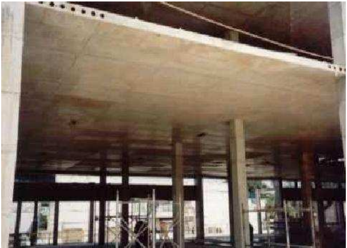
Figura 1.4 – Laje lisa sem vigas internas e de bordo - (CAUDURO – 2002)
