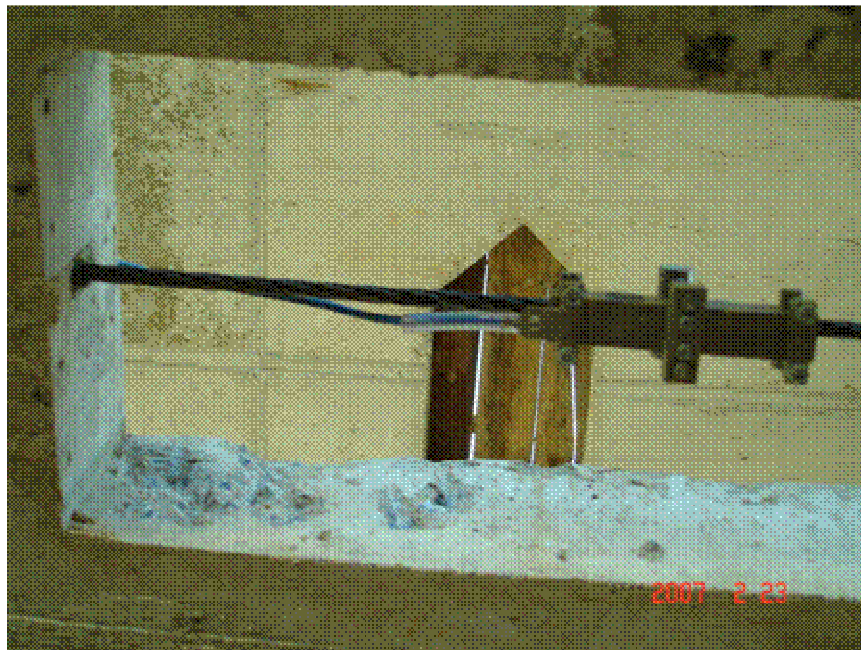
Figura 4.4 – Nicho na laje com a célula de carga no cabo
