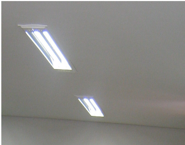
Figura 4.49 – Teto do 2º pavimento sem infiltração.
