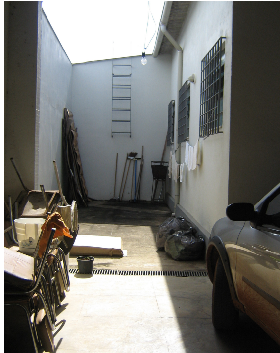
Figura 4.52 – Base da edificação sem infiltração.
