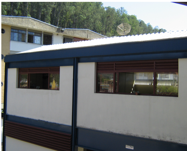
Figura 4.78 – Telhado do Anexo
