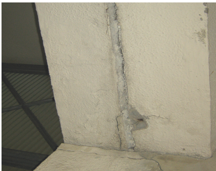
Figura 4.23 – Detalhe da junta de dilatação
