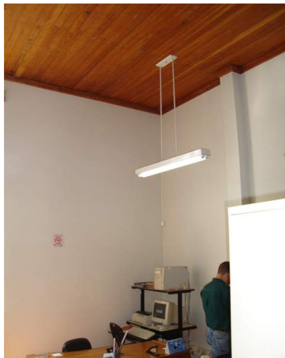
Figura 4.83 – Detalhe da edificação sem apresentação de patologias.
