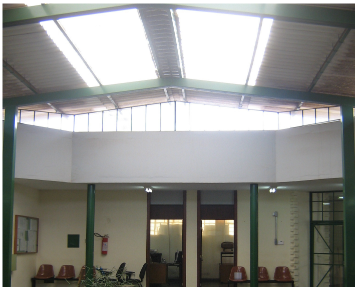
Figura 4.56 – Fechamento com venezianas no lanternim.
