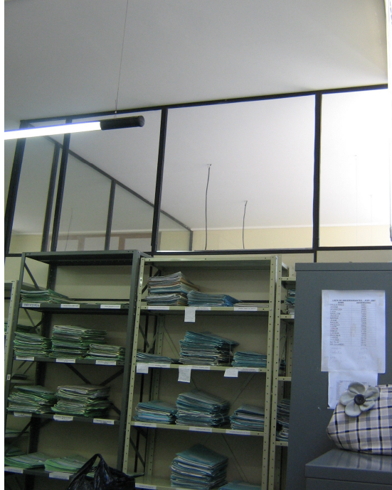
Figura 4.75 – Teto do subsolo sob jardim impermeabilizado
