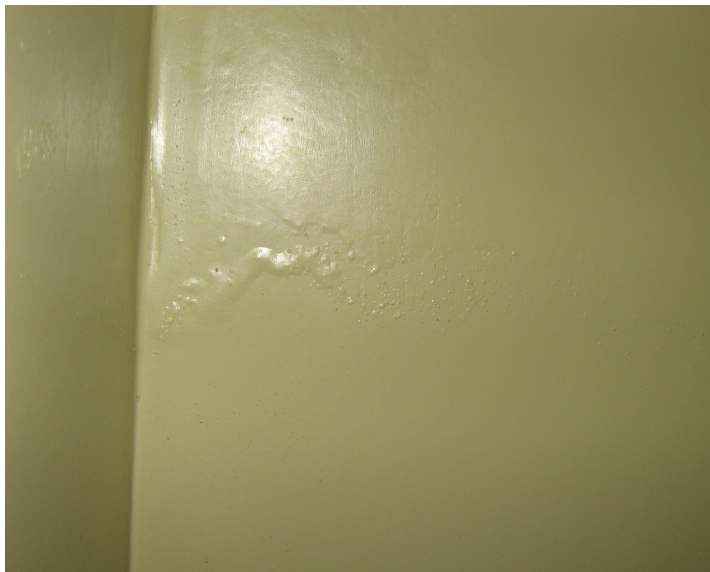
Figura 4.74 – Parede do subsolo com sinais de infiltração
