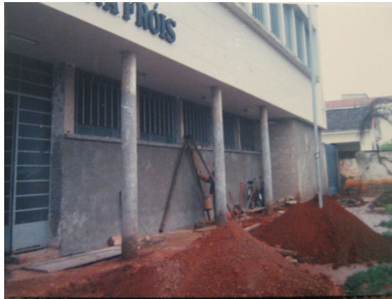
Figura 4.30 – Execução do tubulão para reforço.
