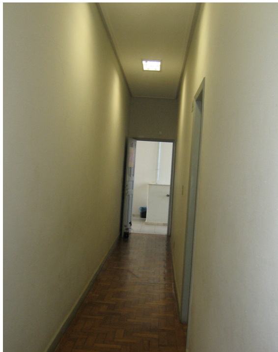
Figura 4.65 – Teto do 2º pavimento sem infiltração.
