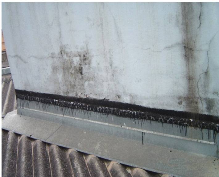
Figura 4.19 – Aplicação de emulsão na ligação do rufo com reservatório superior
