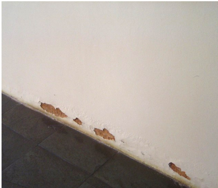
Figura 4.16 – Expansão da argamassa pelo aumento da umidade
