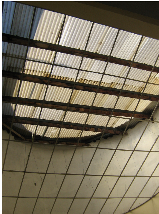
Figura 4.79 – Platibanda da escada central tratada.
