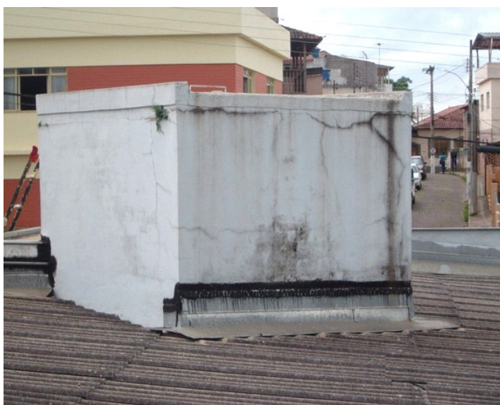
Figura 4.20 – Aplicação de emulsão na ligação do rufo com reservatório superior
