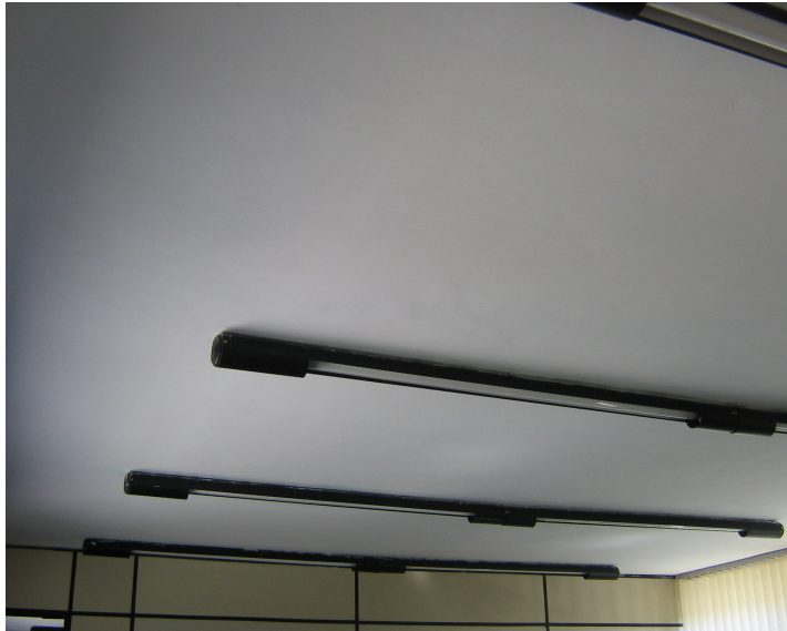
Figura 4.77 – Teto do anexo sem infiltração
