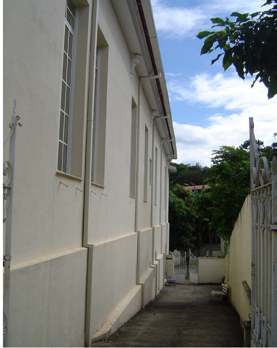
Figura 4.84 – Lateral direita da edificação sem apresentação de patologias.
