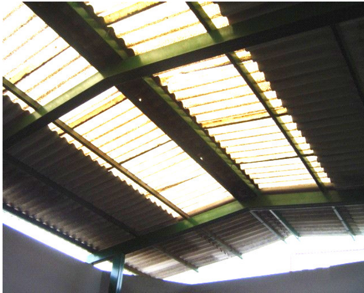
Figura 4.15 – Vista da cobertura central da edificação.
