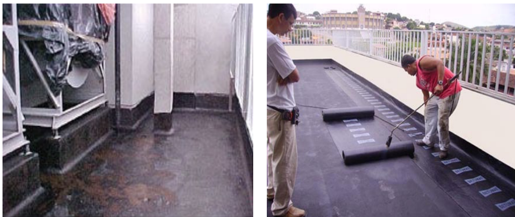
Figura 4.42 – Imprimação e aplicação da manta asfáltica.
