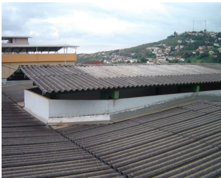
Figura 4.18 – Beiral curto sobre o pátio central.
