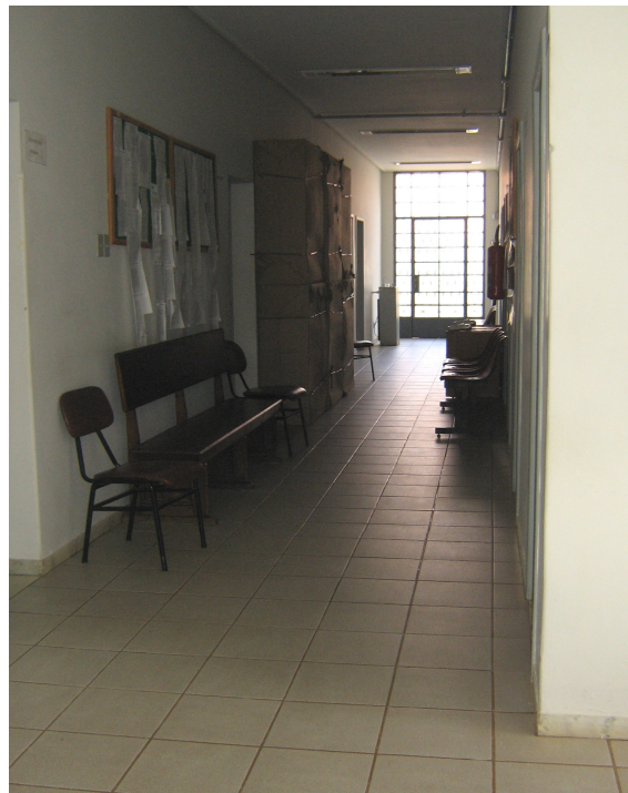
Figura 4.63 – Corredor onde ocorreu reforço de fundação.
