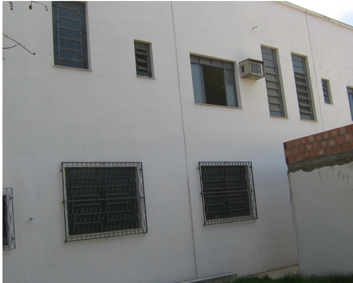
Figura 4.66 – Fachada dos fundos após tratamento.
