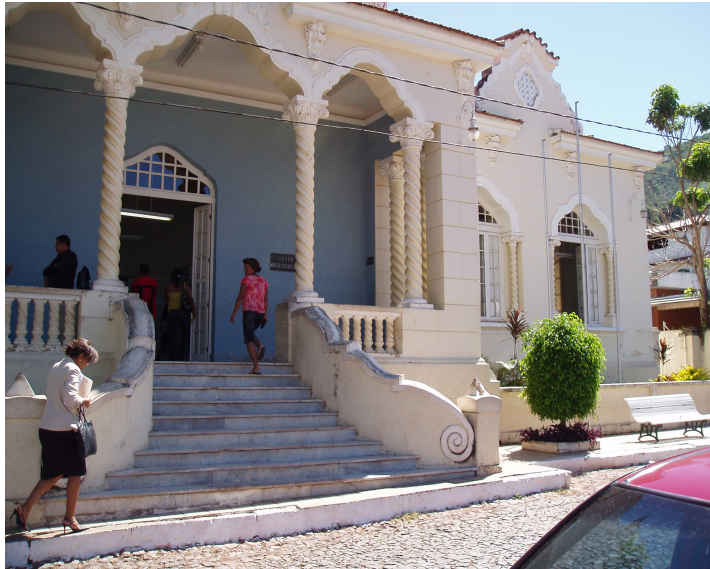
Figura 4.82 – Entrada da edificação sem apresentação de patologias.
