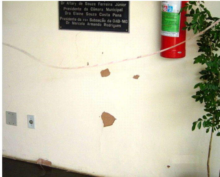
Figura 4.17 – Expansão da argamassa pelo aumento da umidade
