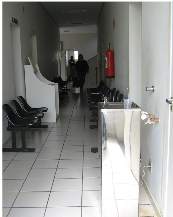
Figura 4.51 – Base da edificação sem infiltração.
