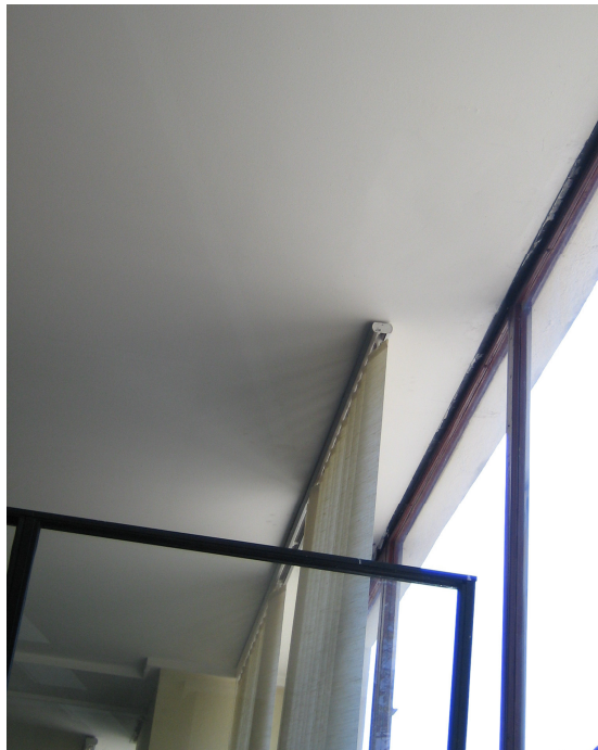
Figura 4.76 – Teto do subsolo sob jardim impermeabilizado
