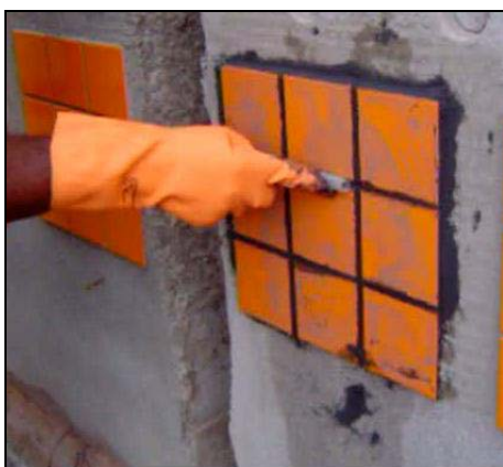
e) frisamento das juntas com haste de plástico.
