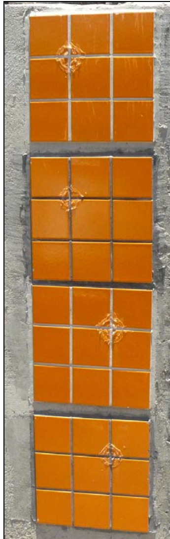
Figura 5.22 – Vista dos 4 painéis executados ao ar livre.
