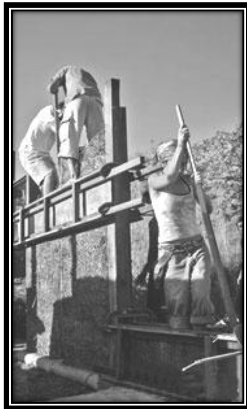
Figura 6 – Fabricação de parede em taipa de pilão
