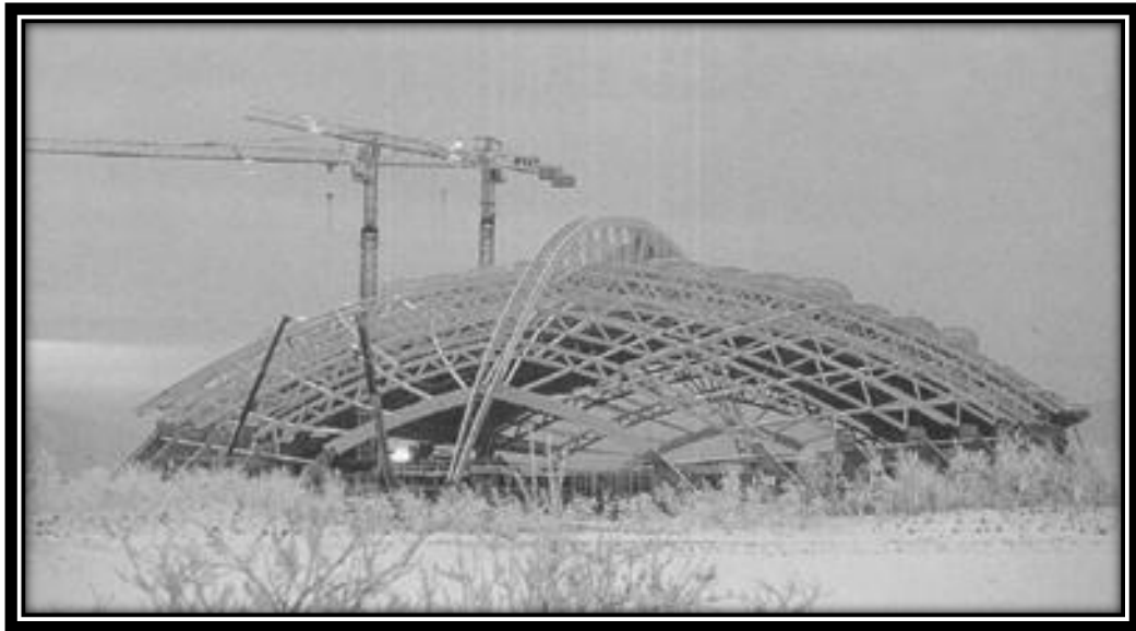
Figura 2 – Ginásio olímpico com estrutura em MLC na Noruega
