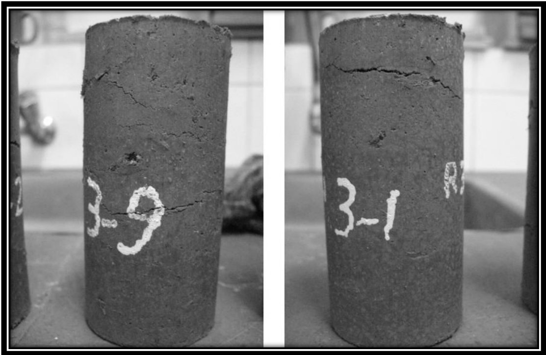
Figura 29 – Fissuração em CPs com 3% de RMCC desmoldados imediatamente após sua confecção
