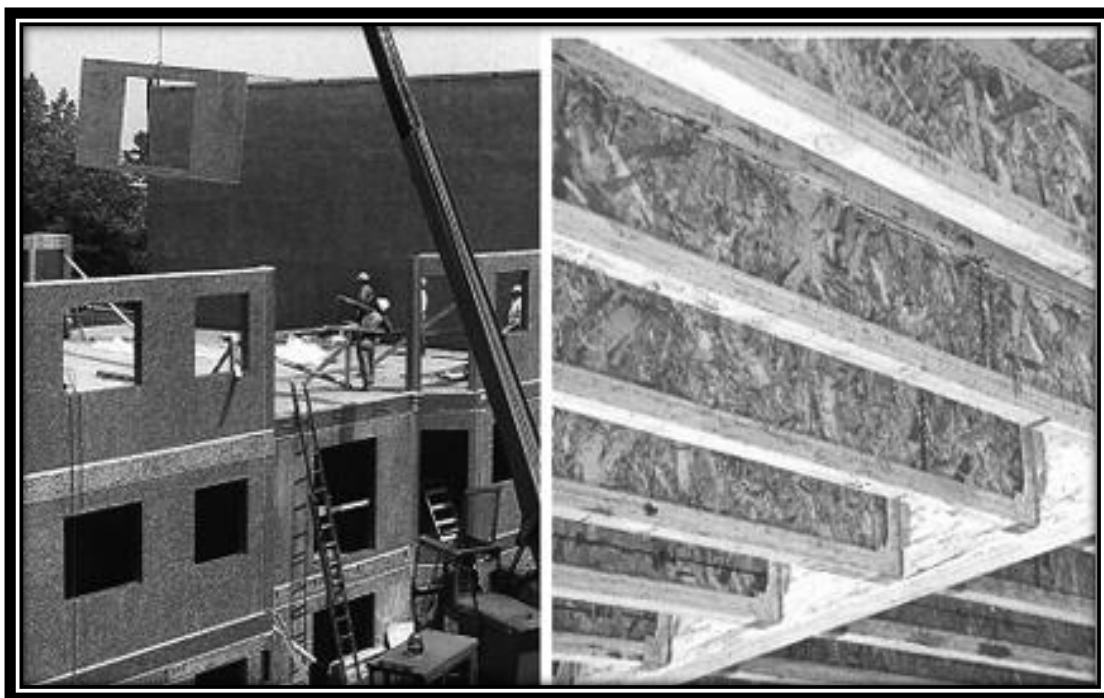
Figura 4 – Aplicação do OSB em painéis pré-moldados para utilização na construção civil. Utilização do OSB na alma de vigas de madeira
