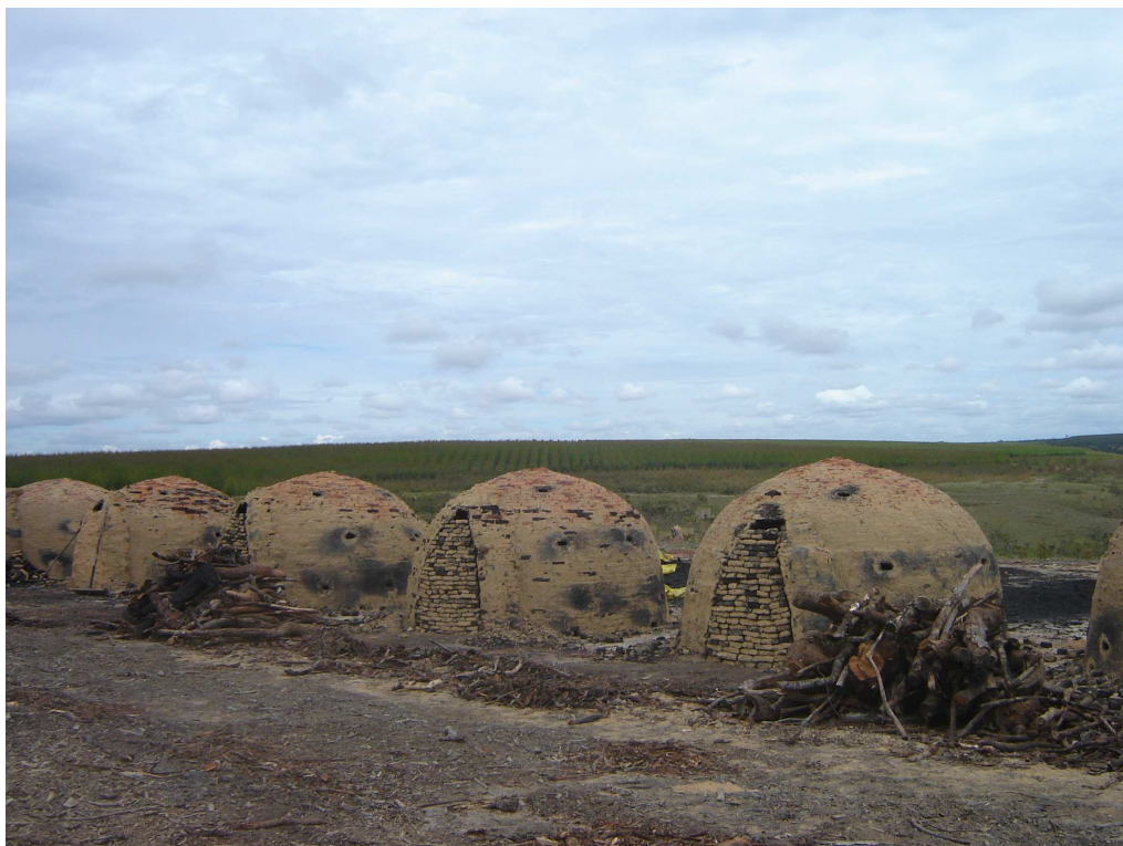
Figura 10 – Vista de baterias de fornos
