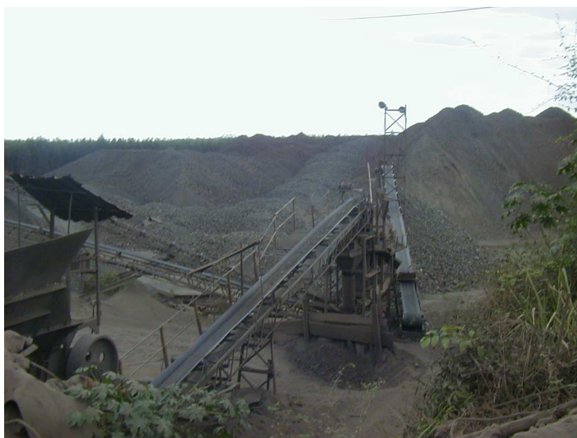
Figura 2 – Pátio para estocagem da escória de alto-forno
