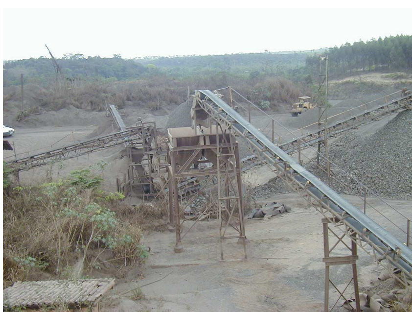
Figura 3 – Pátio para estocagem da escória de alto-forno
