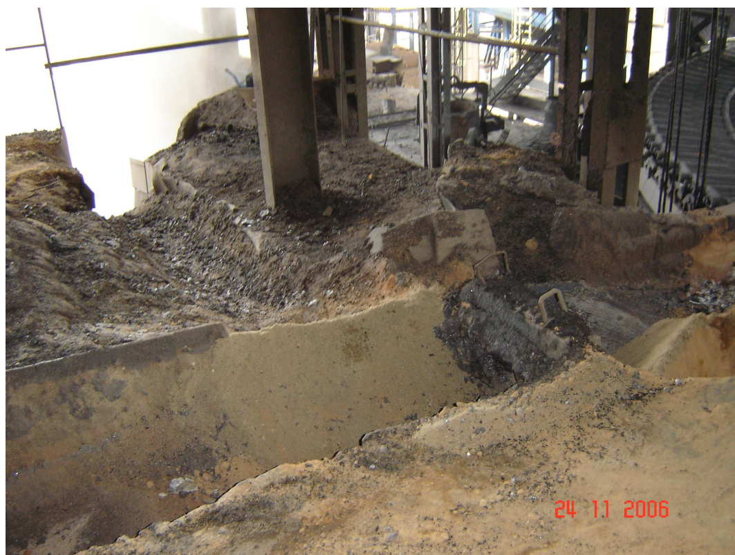
Figura 20 – Vista geral da bica de saída da escória em um alto-forno
