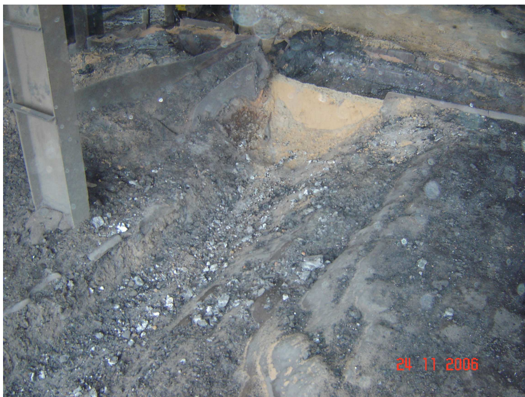
Figura 21 – Detalhe da bica de saída da escória
