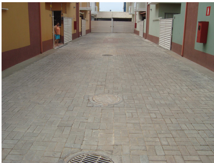
Figura 7 – Obra executada Fonte: Foto produzida pelo autor
