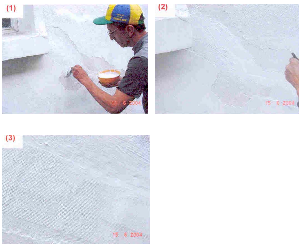
Figura 5.12 - (1) Imprimação; (2) 1ª demão de impermeabilizante acrílico; (3) aplicação da 2ª demão de impermeabilizante acrílico com tela de poliéster com bandagem central (SAHADE, 2005).
