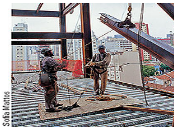
Figura 3.9 – Montagem da estrutura metálica (Téchne, 2008).
