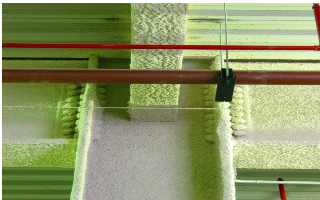
Figura 3.21 – Pilar metálico protegido com argamassa projetada.
