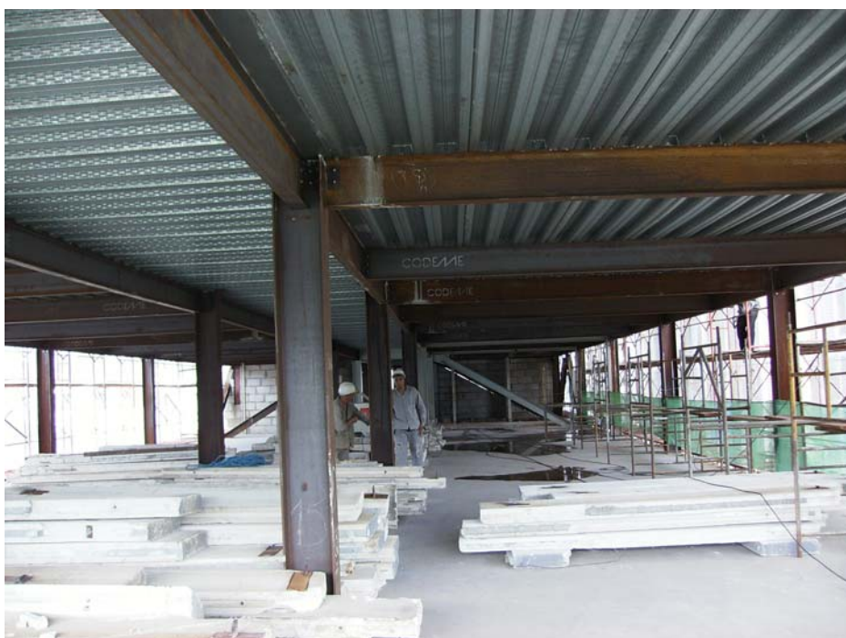
Figura 5.2 - Vista da laje steel deck .
