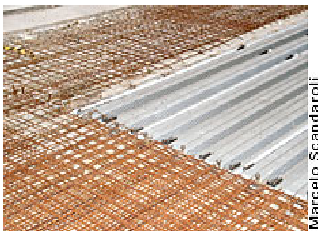
Figura 3.11 – Armaduras adicionais da laje (Téchne, 2008).
