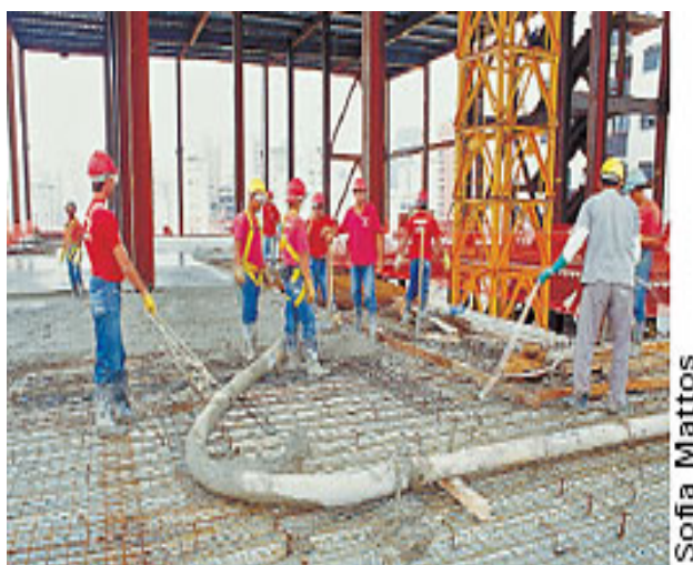
Figura 3.12 – Concretagem da laje steel deck (Téchne, 2008).
