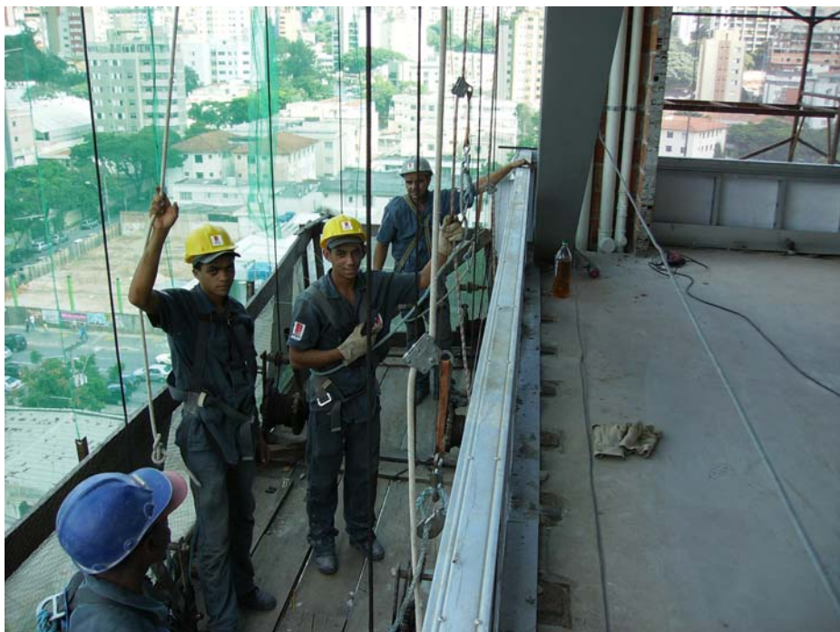
Figura 5.7 - Montagem do Steel Framing .
