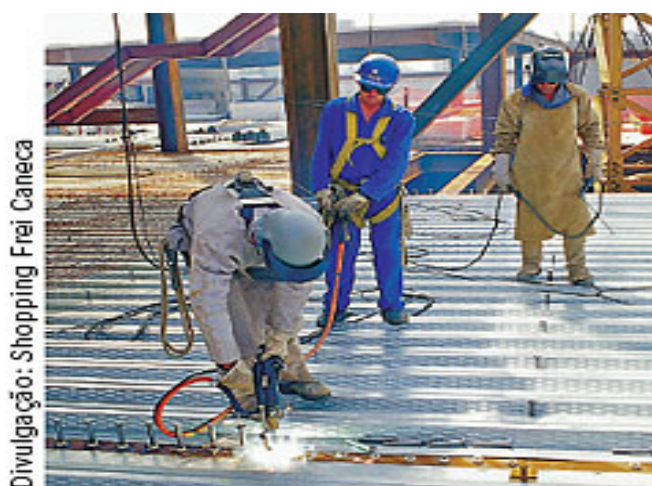
Figura 3.10 – Fixação dos stud bolt (Téchne, 2008).
