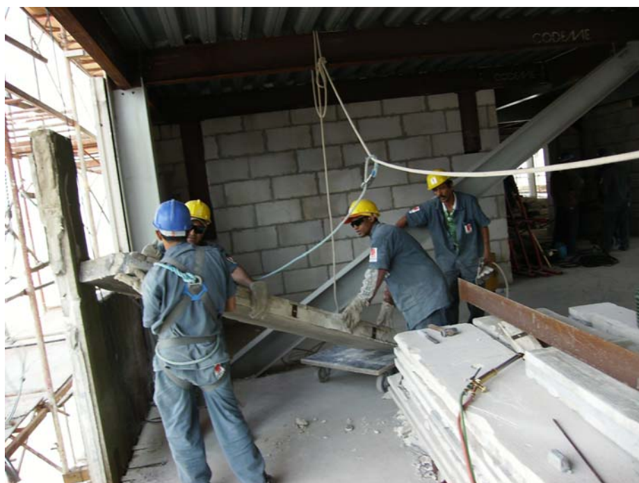
Figura 5.6 - Remoção dos painéis celular autoclavados da fachada.
