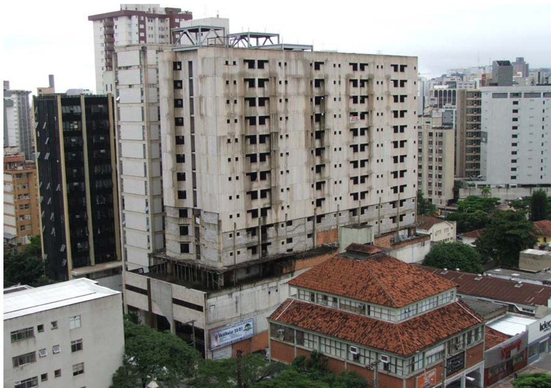
Figura 5.5 - Fechamento externo em painéis de bloco celular autoclavados.
