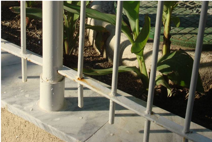
Figura 28 – Detalhe ampliado do guarda-corpo Fonte: Acervo da autora.
