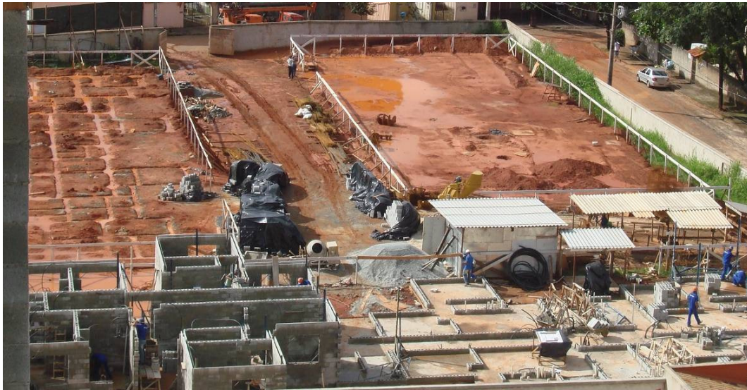
FIGURA 16 – Execução da 1ª fiada do projeto de modulação de alvenaria Fonte: Acervo da autora.
