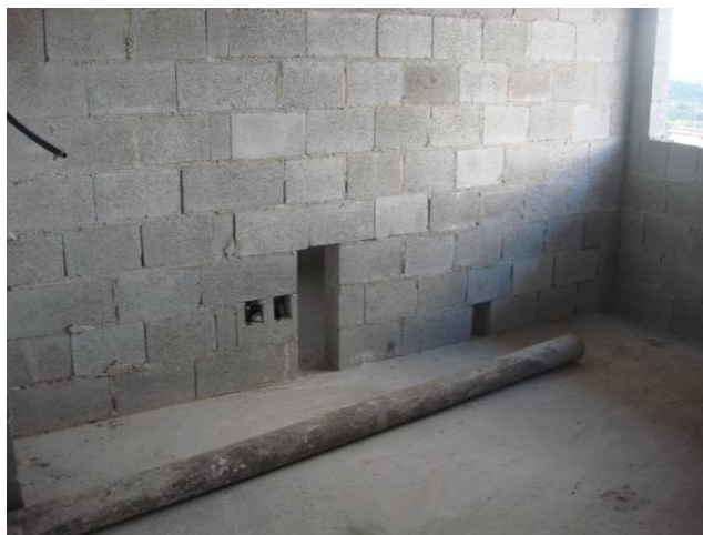
Figura 18 – Execução da alvenaria na obra Fonte: Acervo da autora.
