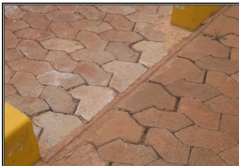
**Figura 9 – Detalhe de coloração do bloquete convencional e de bloquete com rejeito semelhante**
