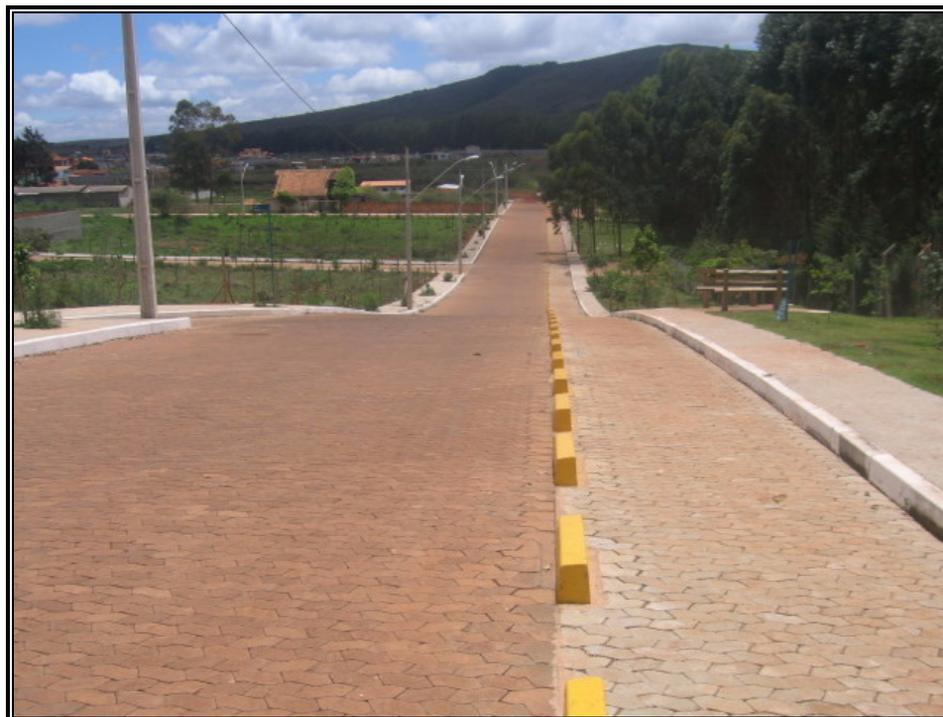
**Figura 51 – Vista de trecho do bairro Jd. Canadá em Nova Lima pavimentado com bloquetes produzidos com material semelhante ao da presente pesquisa**
