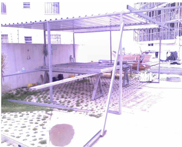
FIGURA 27 – Bancada de montagem de painéis na obra (Fonte: Arquivo do autor, 2009).
