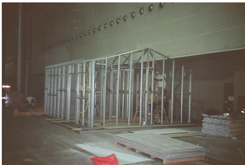
FIGURA 48 – Primeiro dia de montagem do protótipo: execução da base e dos painéis estruturais (Fonte: Arquivo do autor, 2008).
