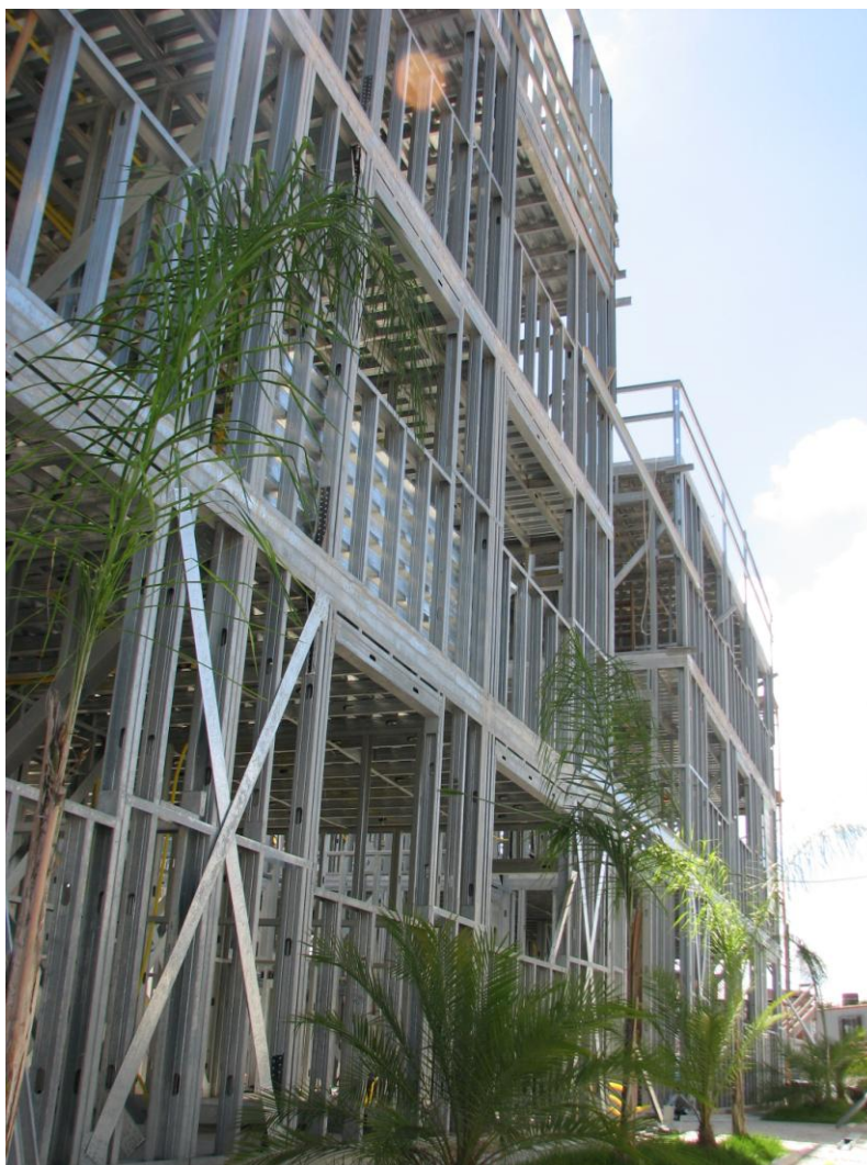
FIGURA 2 – Estrutura de prédio em LSF (Fonte: Arquivo do autor –2008).
