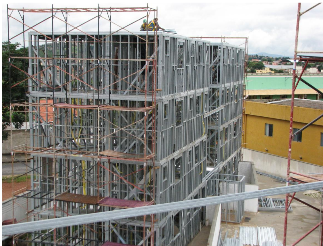
FIGURA 11 – Montagem dos Painéis (Fonte: Arquivo do autor, 2008).
