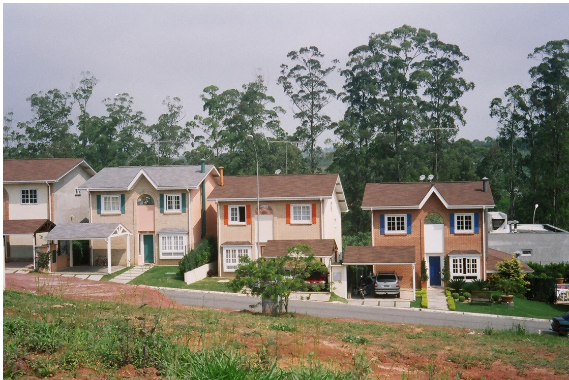
FIGURA 7 – Conjunto de casas em LSF executado pela Construtora Sequência (Fonte: Arquivo do autor, 2007).
