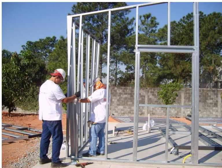
FIGURA 28 – Montagem dos Painéis (Fonte: Saint-Gobain, 2008).
