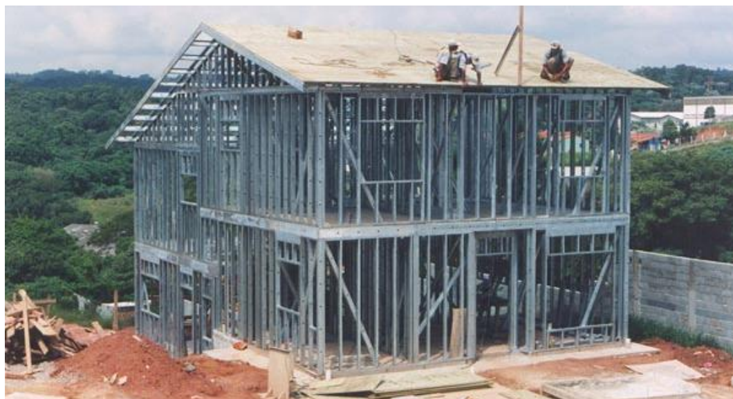
FIGURA 5 – Casa em LSF (Fonte: Construtora Sequência, Granja Viana-SP, 2004).
