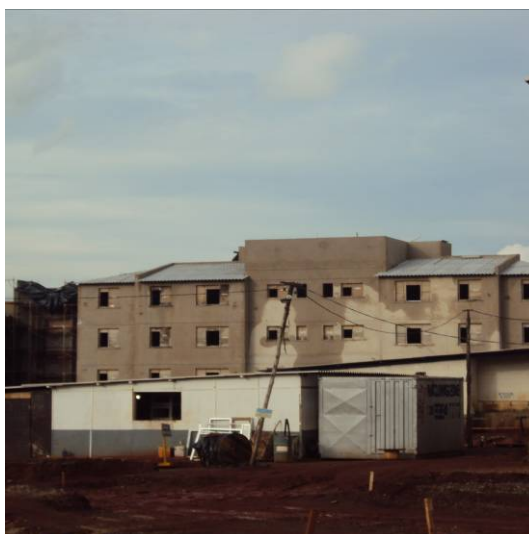
FIGURA 13 – Canteiro de Obras
