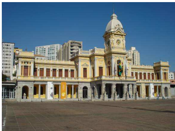
FIGURA 5.13 - Estação Central – MAO 2010
