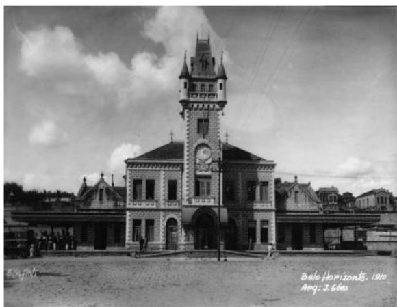
FIGURA 5.1 - Fachada do 1º prédio da Estação - 1910. Fonte: Acervo digital do APCBH.
