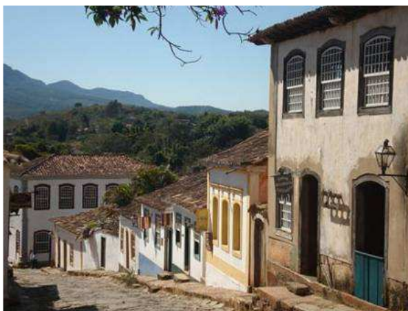
FIGURA 3.7 – Cidade de Tiradentes – Casas construídas no alinhamento da rua.
