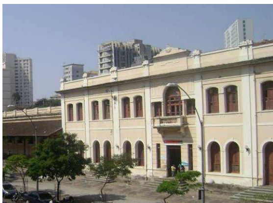
FIGURA 5.19 - Prédio Anexo a Estação Central.
