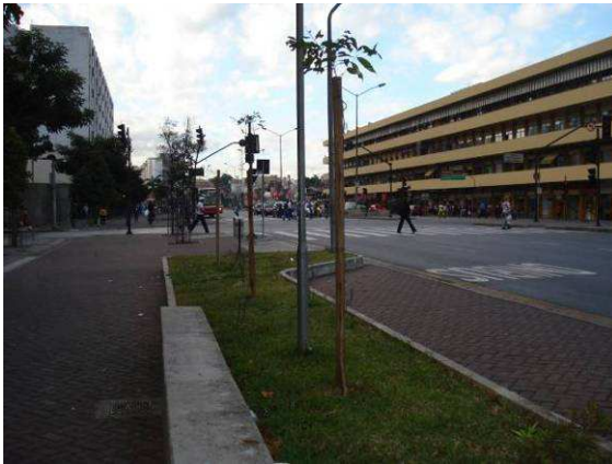
FIGURA 5.28 – Calçadas mais largas, novo revestimento, faixas de travessias e novos canteiros.
