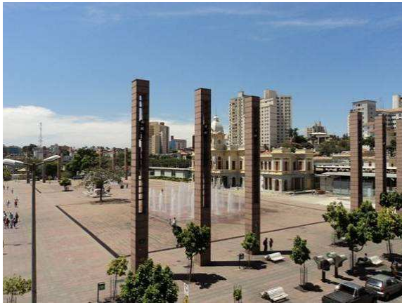
FIGURA 5.22 – Área da Esplanada – torres de iluminação e fontes.
