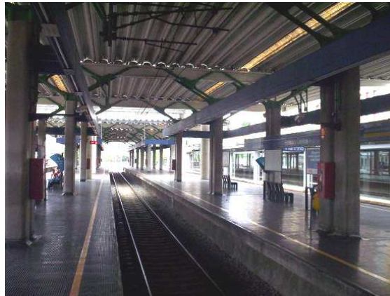
FIGURA 5.17 - Plataforma do metrô
