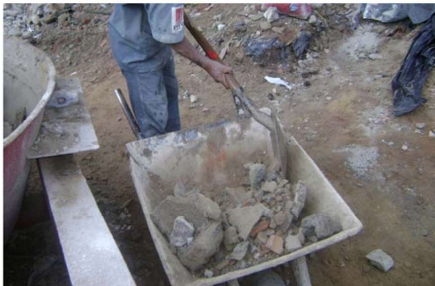
Figura 17 – RCC sendo colocado no moinho/argamassadeira.
