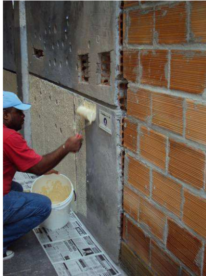
Figura 12 - Aplicação da textura acrílica
