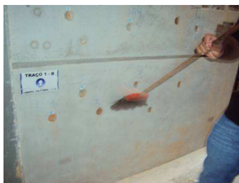
Figura 5 - Limpeza das superfícies
