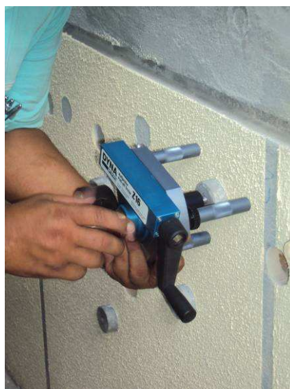
Figura 17 - Ensaio de resistência de aderência à tração (pull-off)
