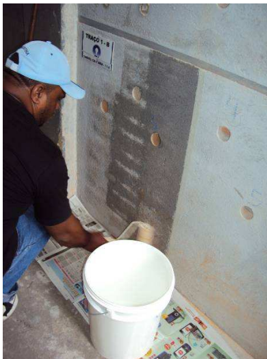
Figura 7 - Aplicação do fundo preparador de paredes
