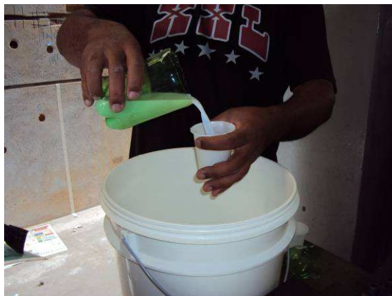
Figura 10 - Preparo do fundo preparador de paredes
