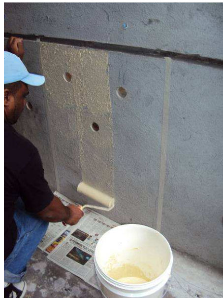
Figura 9 - Aplicação do selador com a própria textura diluída
