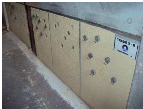
Figura 16 - Visão geral dos painéis com os discos colados
