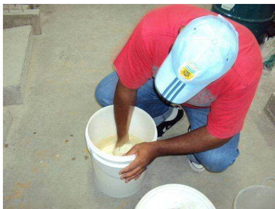
Figura 11 - Preparação da textura acrílica
