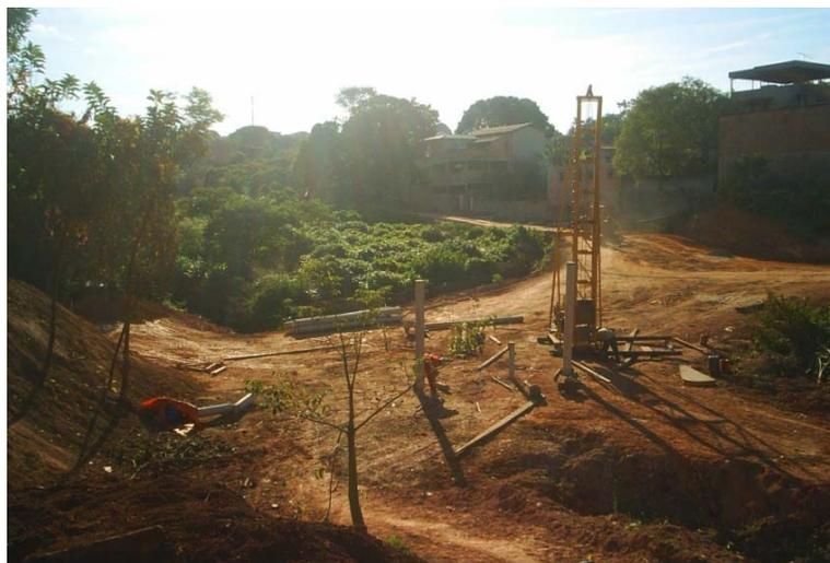
**FIGURA 60:** Obras de terraplanagem e estruturais – cravação de estacas para as fundações da Barragem – calha do Córrego Primeiro de Maio.
