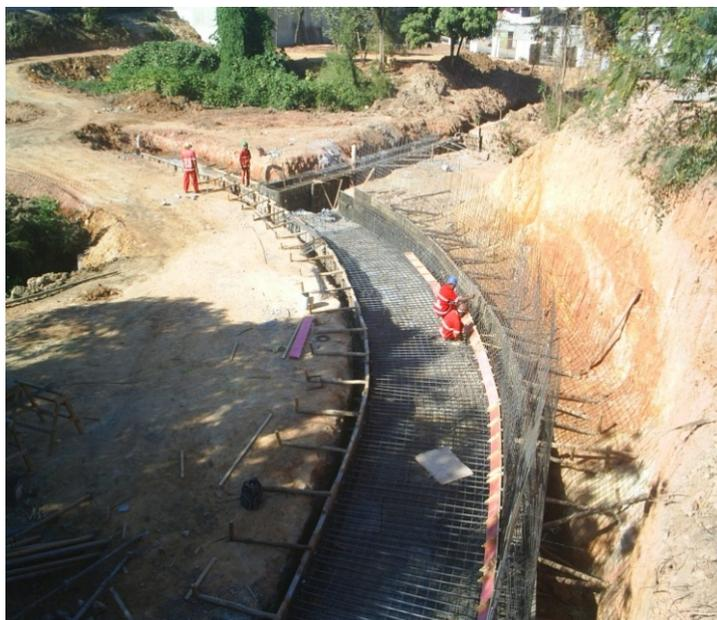
**FIGURA 61:** Obras estruturais – armação das estruturas da Barragem – calha do Córrego Primeiro de Maio – 2007 e canal final para macro drenagem.
