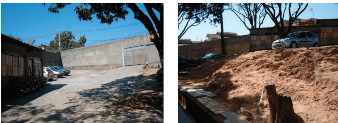
Figura 5-3 – Fotos do estacionamento a ser reformado
