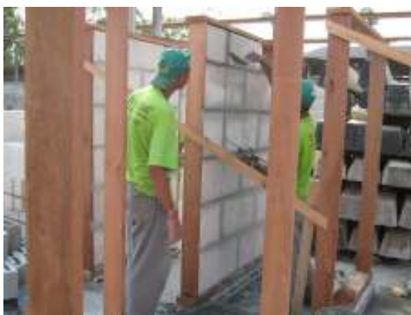
FIGURA 4.24 – Construção das paredes BCCA
