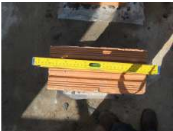
FIGURA 4.18 – Verificação do nível
