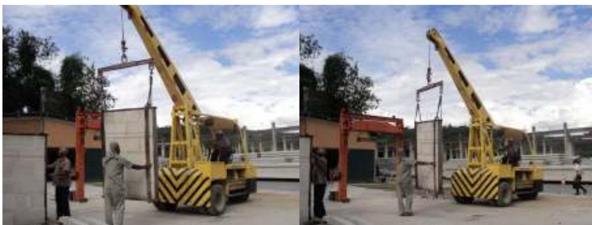
FIGURA 4.25 – Transporte das paredes BCCA
