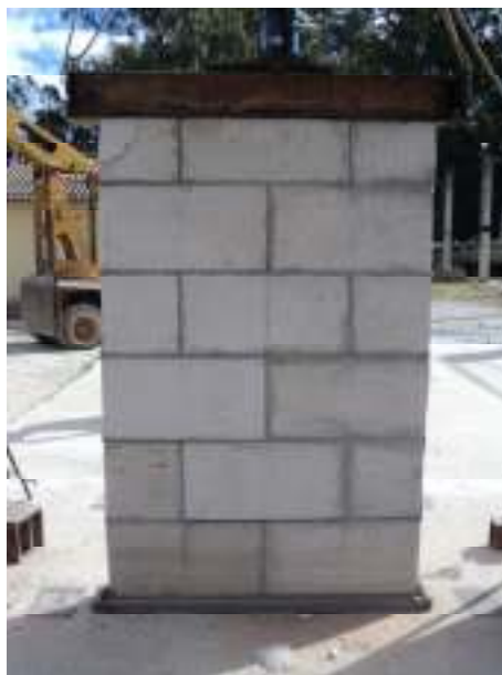
FIGURA 4.27 – Ensaio de compressão das paredes BCCA: ruptura – argamassa industrial
