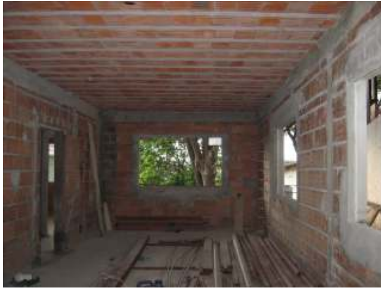
FIGURA 1.1 – Alvenaria de vedação. 2010.
