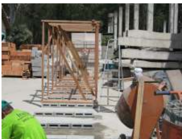
FIGURA 4.23 – Suporte de madeira para transporte das paredes
