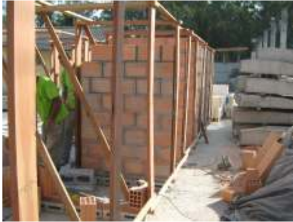
FIGURA 4.29 – Construção das paredes cerâmicas
