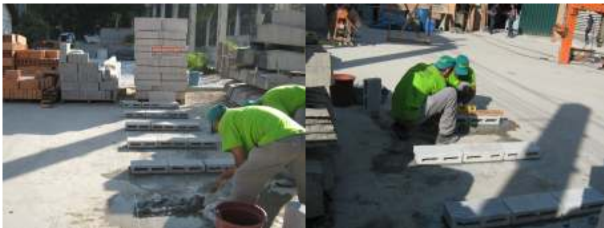
FIGURA 4.22 – Suporte para nivelamento das paredes
