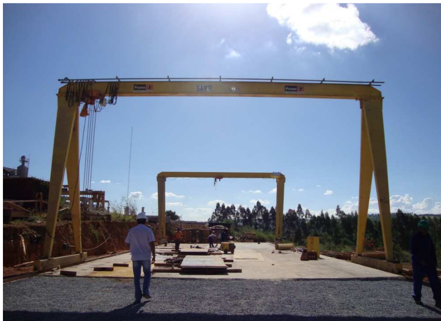
Fig. 21 – Pórtico para movimentação dos painéis
