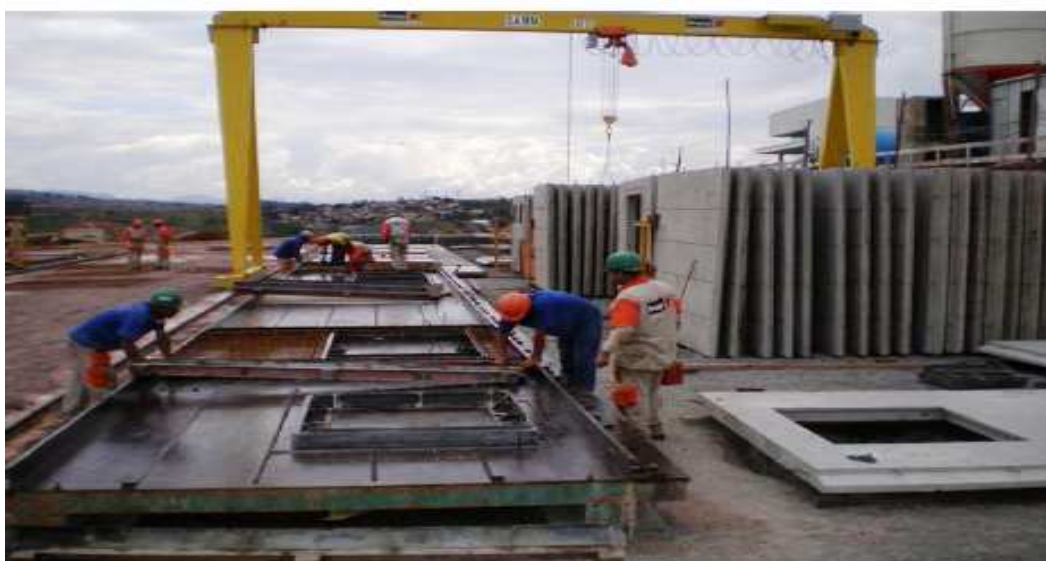
Fig. 20 – Fabricação em pista e bateria
