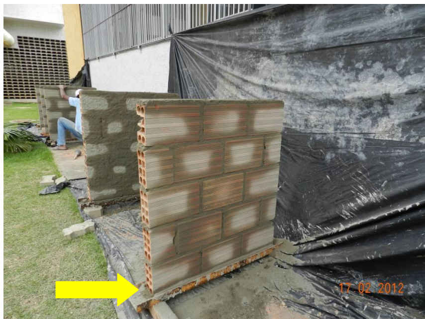
Figura 116 - Utilização de perfil "U" na parte inferior da parede.
