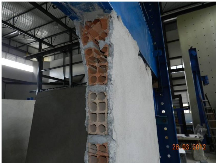
Figura 96 - Formato do rompimento dos septos dos blocos na PAR-3.
