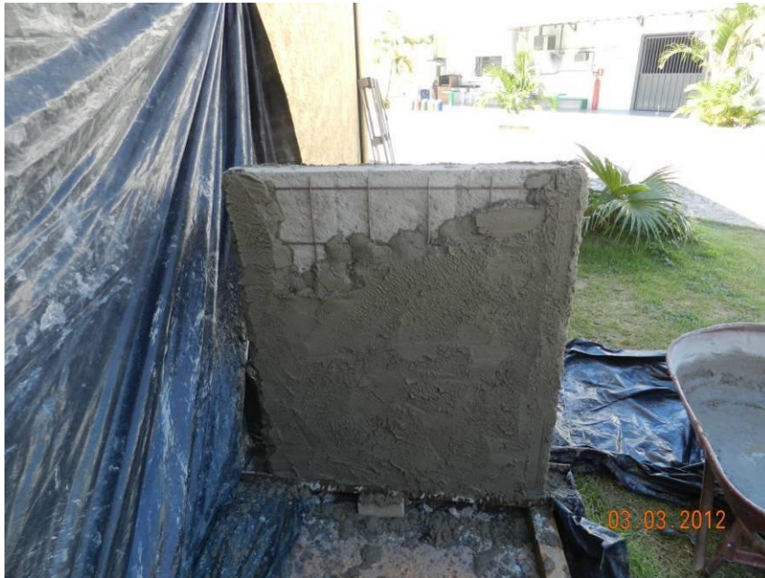
Figura 70 - Tela soldada imersa no reboco.
