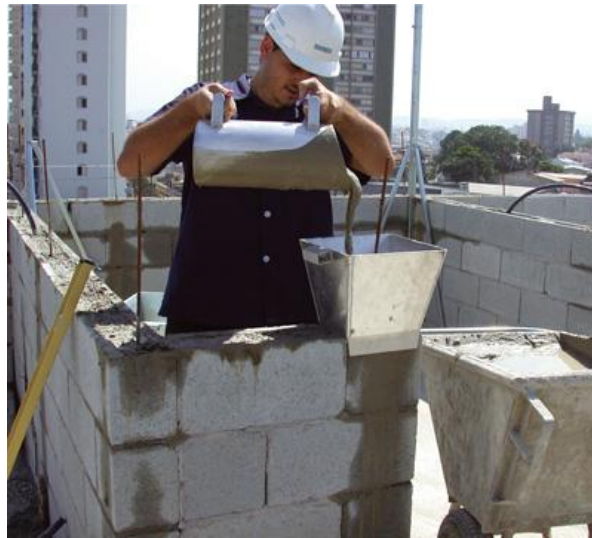
Figura 17 - Grauteamento de alvenaria estrutural de blocos de concreto. 12
