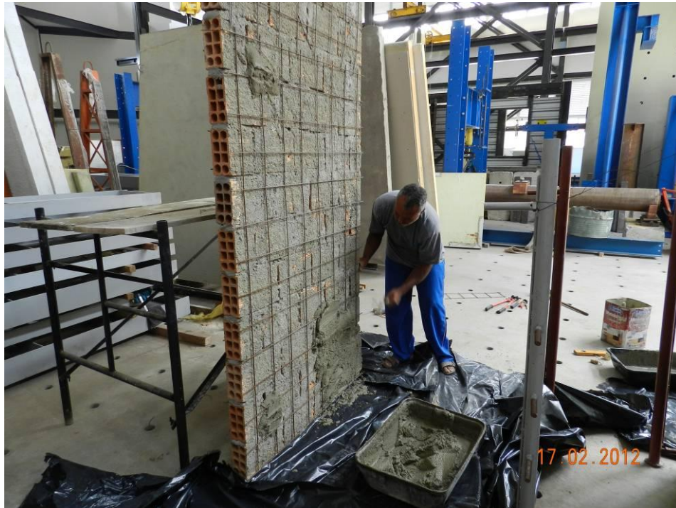
Figura 92 - Execução da parede PAR-3, com tela na argamassa.
