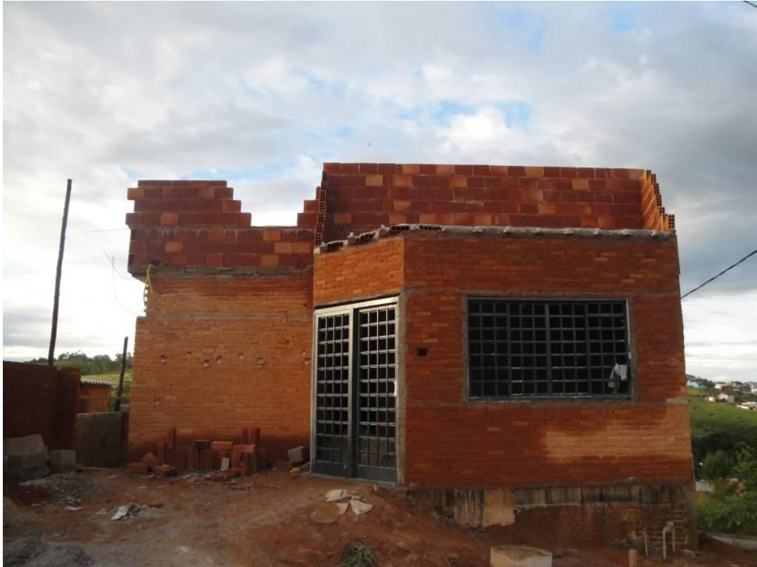
Figura 50 - Construção utilizando tijolo maciço como elemento de alvenaria estrutural. Acervo próprio.
