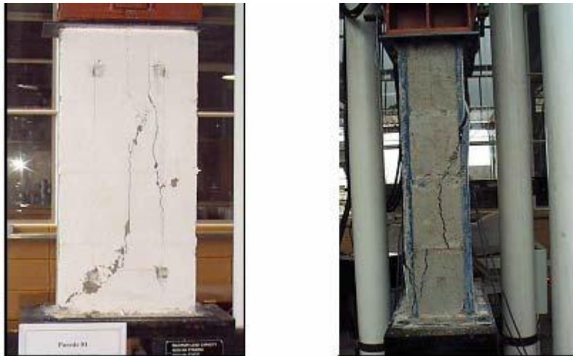
Figura 57 - Fissuras após ensaio. A foto da esquerda indica a parede sem revestimento e a da direita a parede com argamassa armada. Extraído de OLIVEIRA (2001).
