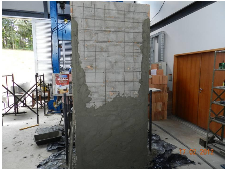
Figura 67 - Visão geral da parede cujo revestimento ganhou reforço de tela em ambos os lados. PAR-3
