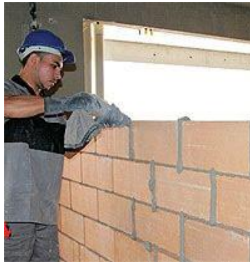
Figura 5 - Execução de alvenaria de vedação utilizando blocos cerâmicos. 6
