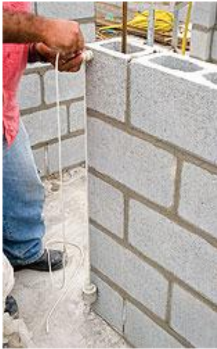
Figura 6 - Execução de alvenaria estrutural utilizando bloco de concreto. 7
