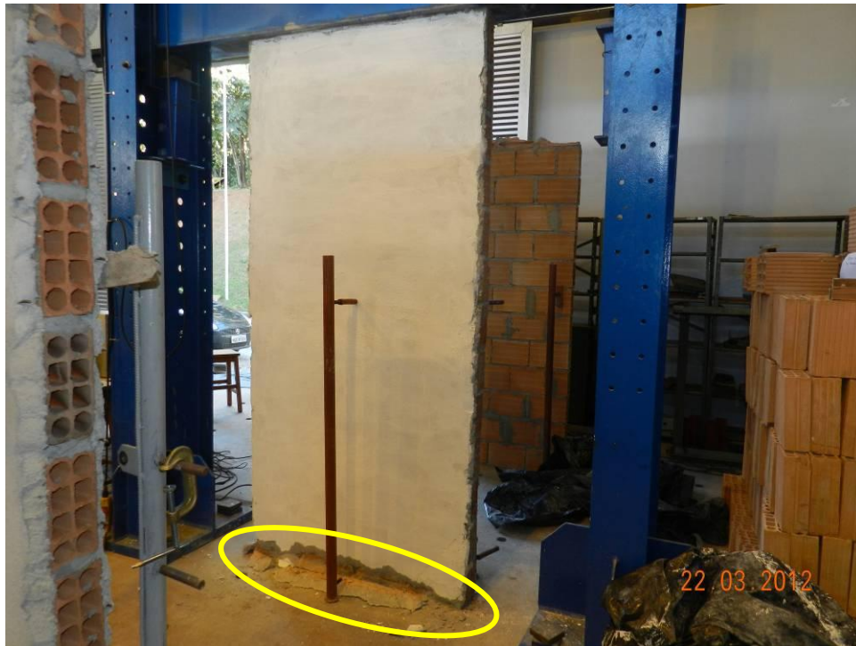
Figura 89 - Deslocamento de parte do reboco no pé da parede PAR-2.
