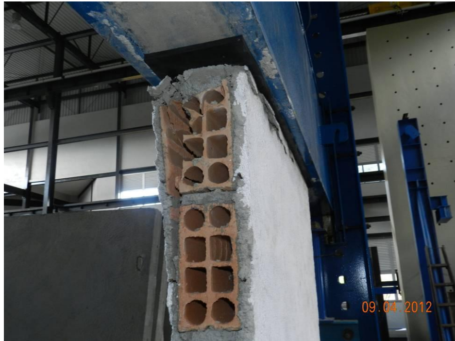
Figura 108- Separação do reboco armado da parte central da alvenaria.
