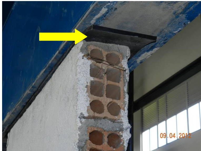
Figura 113 - Utilização de neoprene na parte superior da parede.
