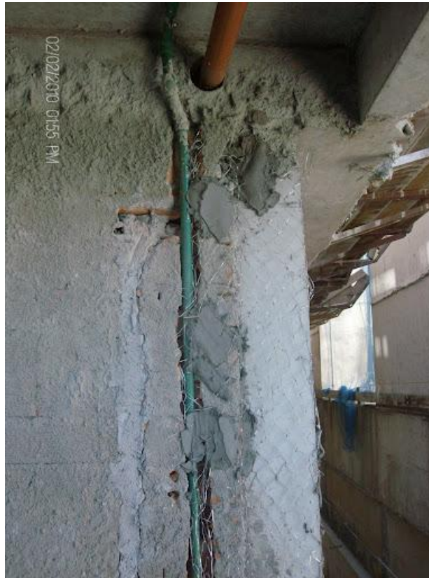
Figura 52 - Revestimento usando tela com o objetivo de reforçar a conexão entre parede e pilar. 20
