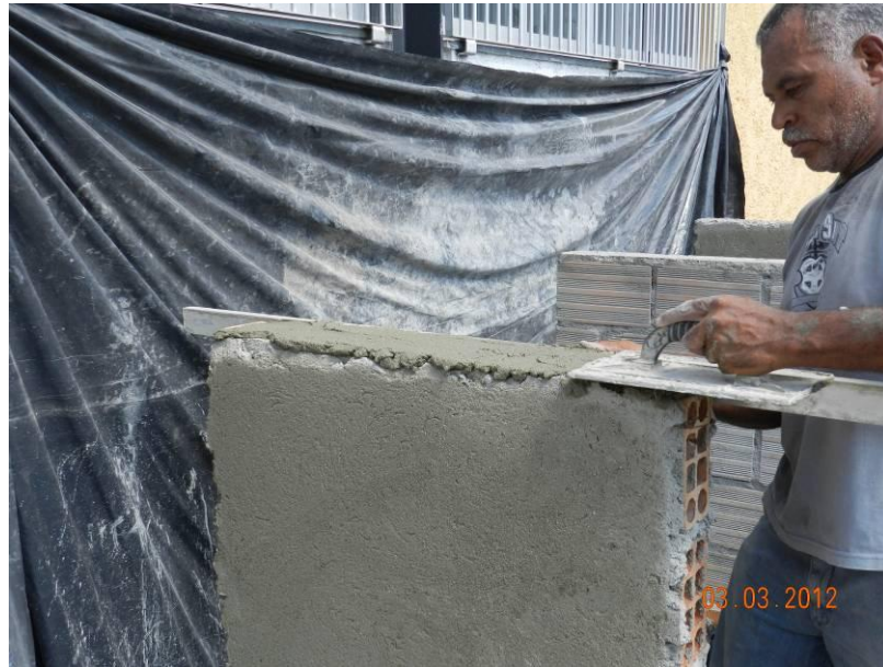
Figura 101 - Confeção de capeamento nas paredes visando a distribuir melhor as tensões.
