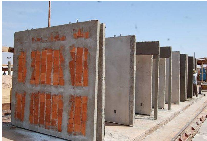
Figura 2 - Painéis pré-moldados de alvenaria. 3
