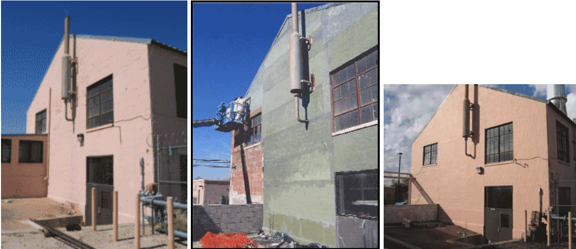
Figura 59 - Recuperação de ala do Medical Center, Tucson, Arizona, com a utilização de fibras e epóxi. Extraído de ESHANI (2005)
