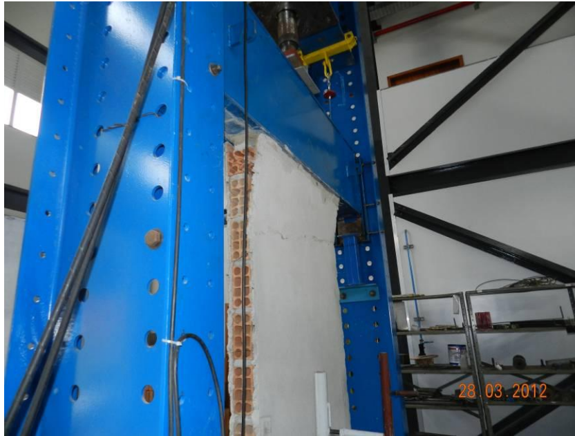
Figura 95 - Deslocamento do reboco na parte superior da PAR-3.
