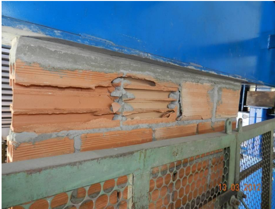
Figura 85 - Face oposta à da parede indicada na figura anterior - PAR-1.
