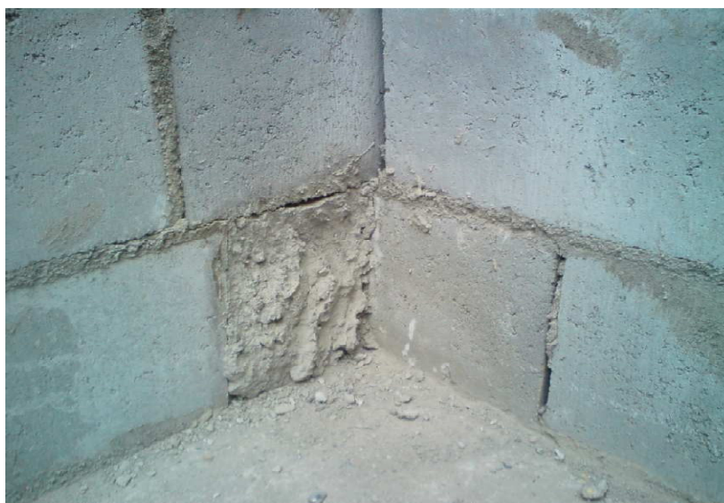
Figura 5.37: Janela de inspeção totalmente preenchida com micro concreto.
