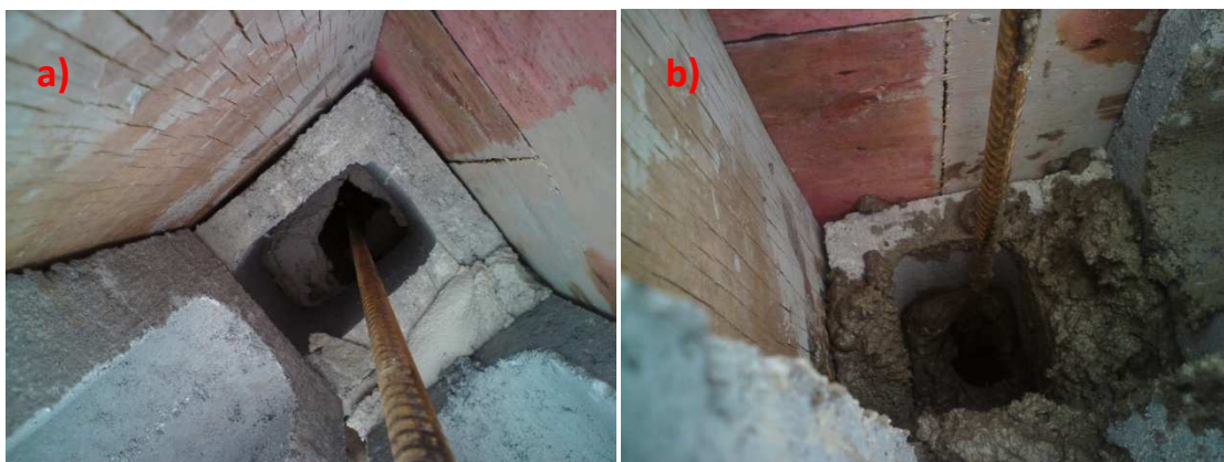
Figura 5.35: a) Vista superior do bloco a ser preenchido com micro concreto. b) Vista superior do bloco de concreto no momento do preenchimento com micro concreto.
