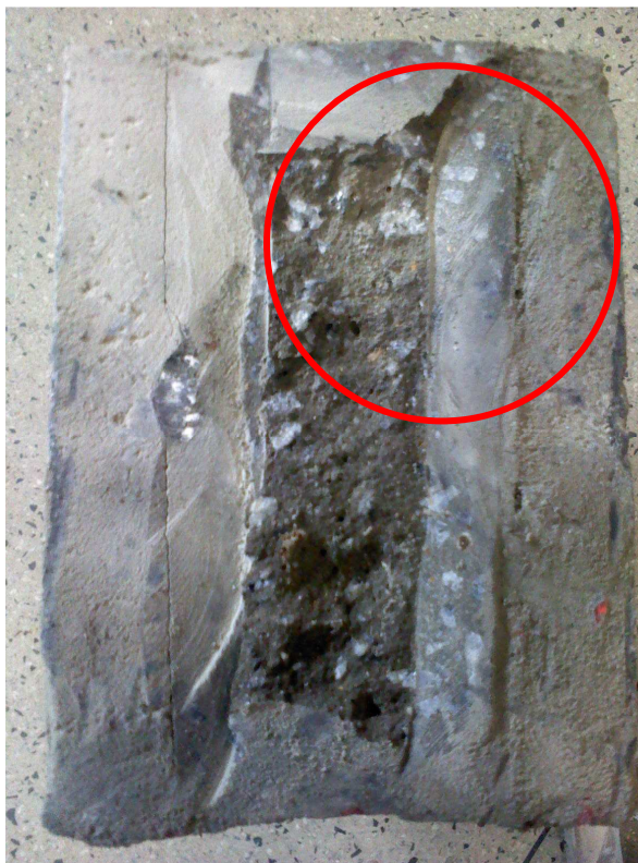
Figura 6.36: Aspecto visual do interior do bloco de concreto preenchido com micro concreto, traço B2, após saturado em água por 24 horas e cerrado.
