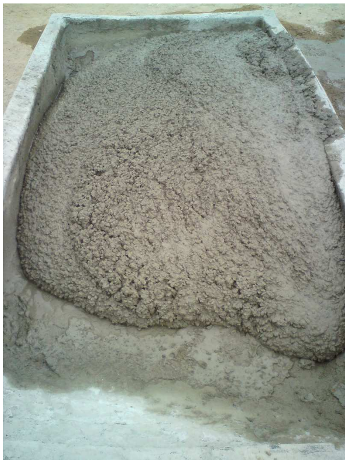
Figura 5.34: Traço padrão com A/C = 0,5 confeccionado na obra.
