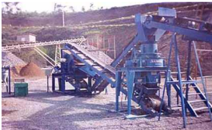
Figura 4.13 – Britagem – Etapa do processo de extração de pedra britada. Fonte: RODRIGUES, 2011.
