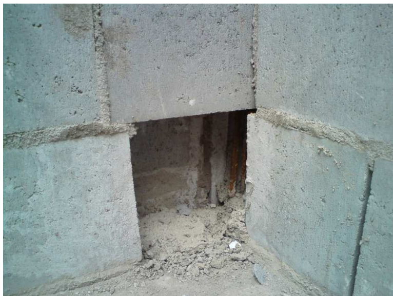
Figura 5.36: Janela de inspeção aberta na base da parede.
