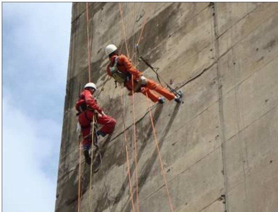
Figura 11 – Realização de inspeção utilizando técnicas de rapel. (Fonte: Empresa Recuperação Engenharia.)
