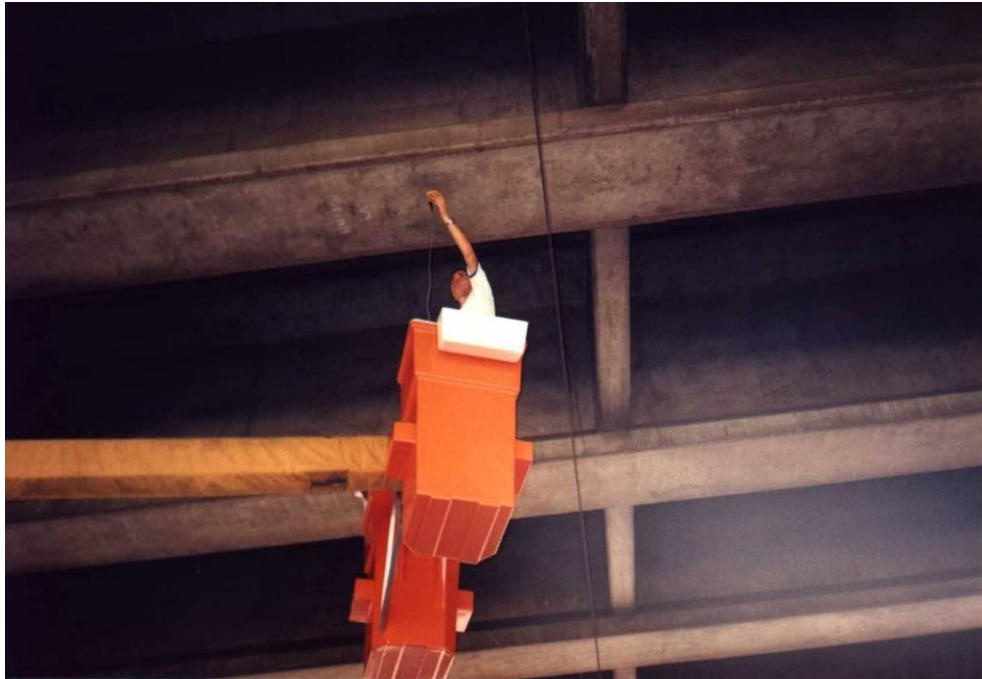
Figura 31 – Inspeção utilizando plataforma elevatória. (Fonte: Empresa Recuperação Engenharia.)
