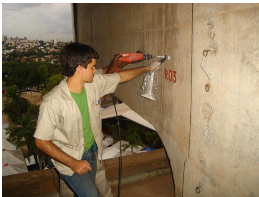
Figura 10 – Extração de amostra de pó concreto em estrutura.
