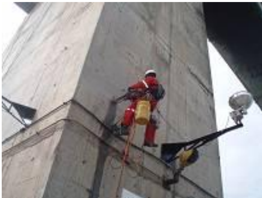
Figura 32 – Inspeção utilizando técnicas de alpinismo.
