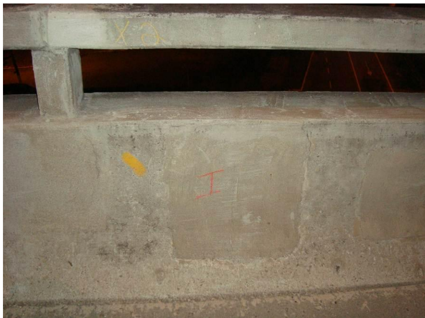
Figura 34 – Local escolhido para o ensaio I, sobre reparo executado anteriormente, (aproximadamente 5 anos).
