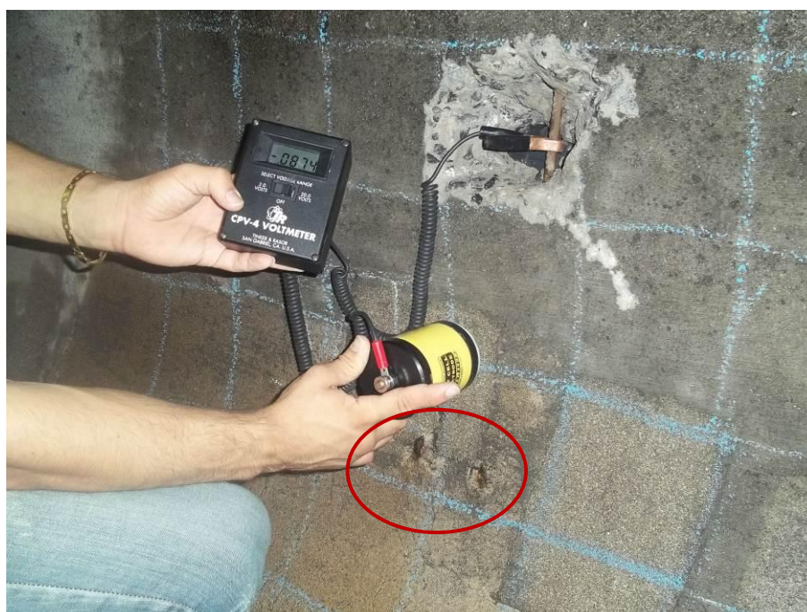
Figura 35 – Detalhe da execução do ensaio I, próximo ao reparo em área com pontos de armaduras expostas em processo de corrosão, porém medimos um valor de -0,0874mV.
