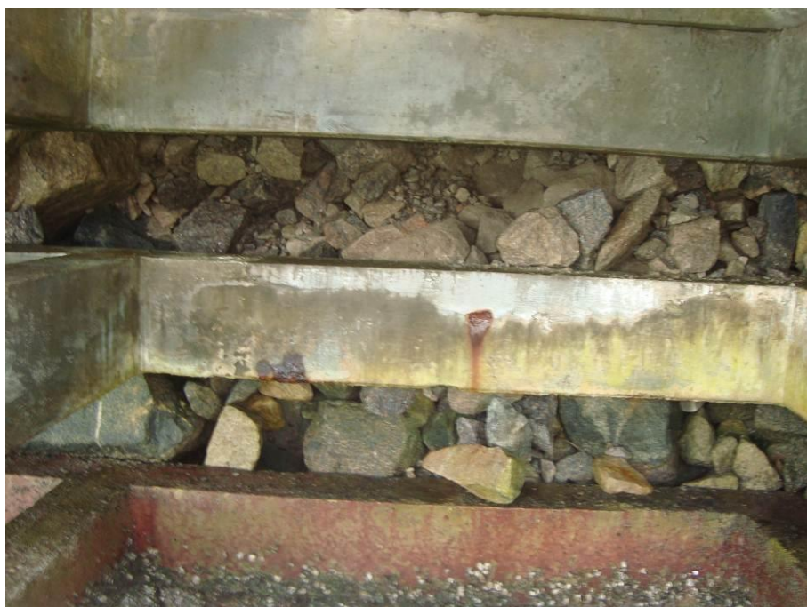
Figura 28 – Efeito da macrocélula observada em um dos blocos próximo a zona marinha. (Fonte: Empresa Recuperação Engenharia)
