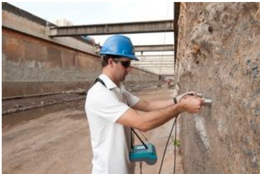
Figura 19 – Ensaio de ultrassonografia por transmissão indireta, para análise da compacidade do concreto das paredes do Ribeirão Arrudas.
