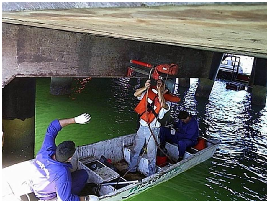
Figura 8 – Extração de amostra de concreto para realização de ensaios. (Fonte: Empresa Recuperação Engenharia.)
