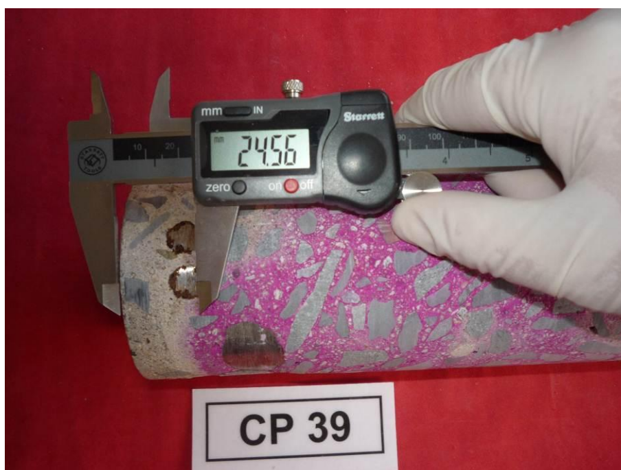
Figura 17 – Corpo de prova onde fica nítida a corrosão nos locais onde a frente de carbonatação já ultrapassou o limite das armaduras. No local onde o aço encontra-se imerso em uma zona com \text{pH} > 9 o aço encontra-se íntegro.
