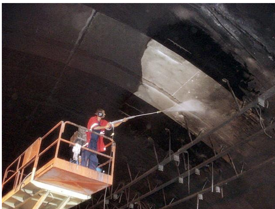
Figura 25 – Limpeza das superfícies de concreto em ambiente repleto de fuligem para o início dos tratamentos.
