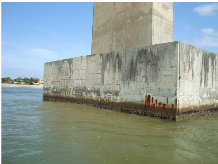
Figura 28 – Efeito da macrocélula observada em um dos blocos próximo a zona marinha. (Fonte: Empresa Recuperação Engenharia)
