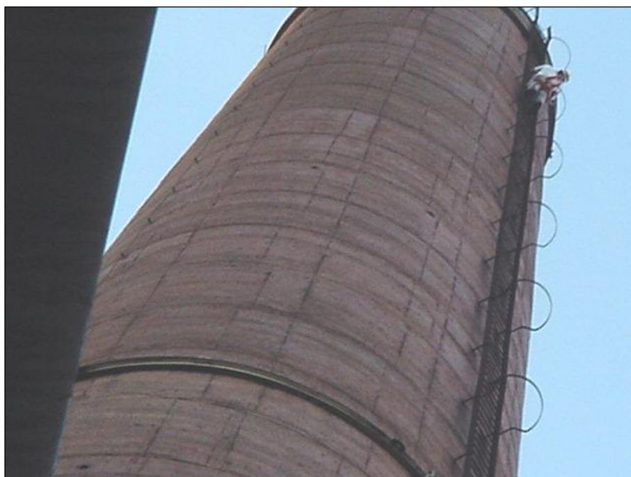
Figura 12– Realização de inspeção utilizando técnicas de alpinismo. (Fonte: Empresa Recuperação Engenharia.)
