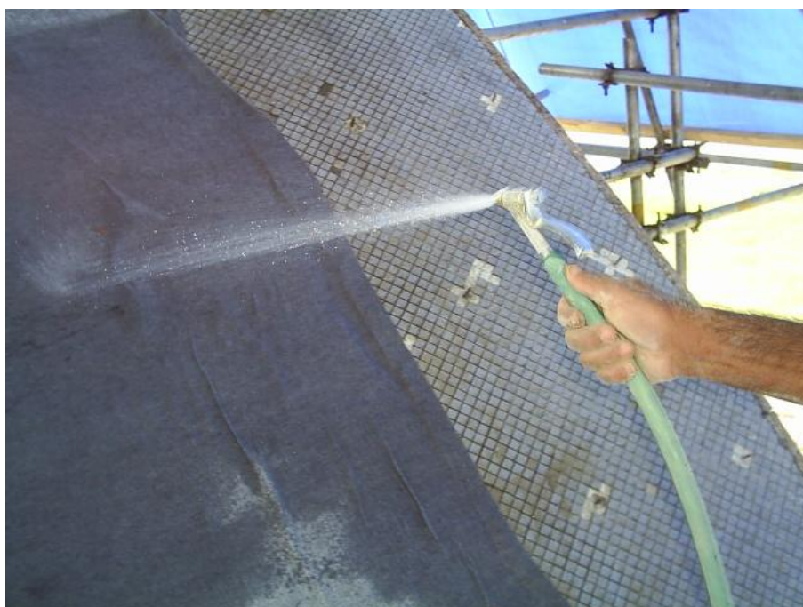
Figura 27 – Técnica que garante a correta cura dos reparos.
