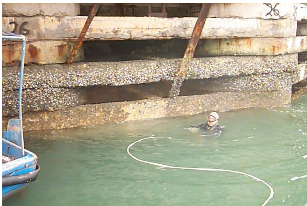
Figura 30 – Técnicas de mergulho profissional para realizar a inspeção subaquática, nas fundações da 3ª Ponte de Vitória.
