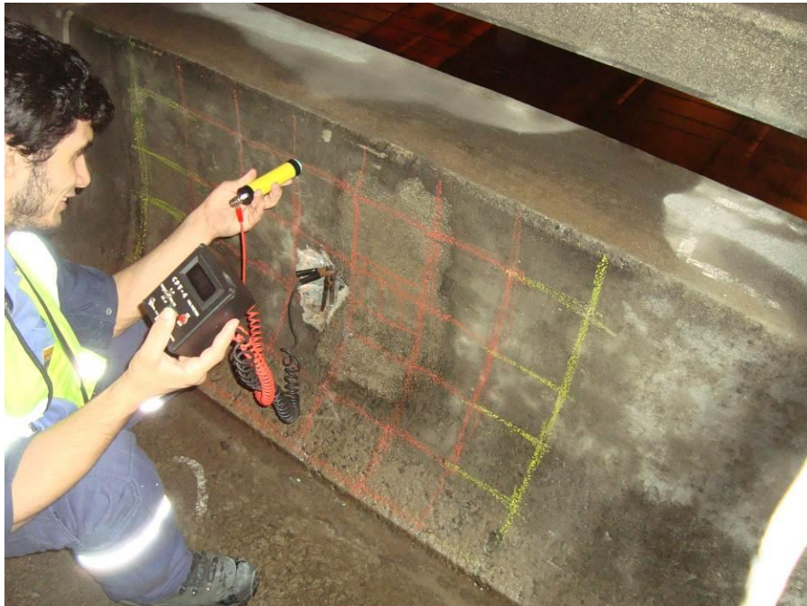
Figura 41 – Local escolhido para o ensaio III, próximo ao reparo executado anteriormente (aproximadamente 5 anos).
