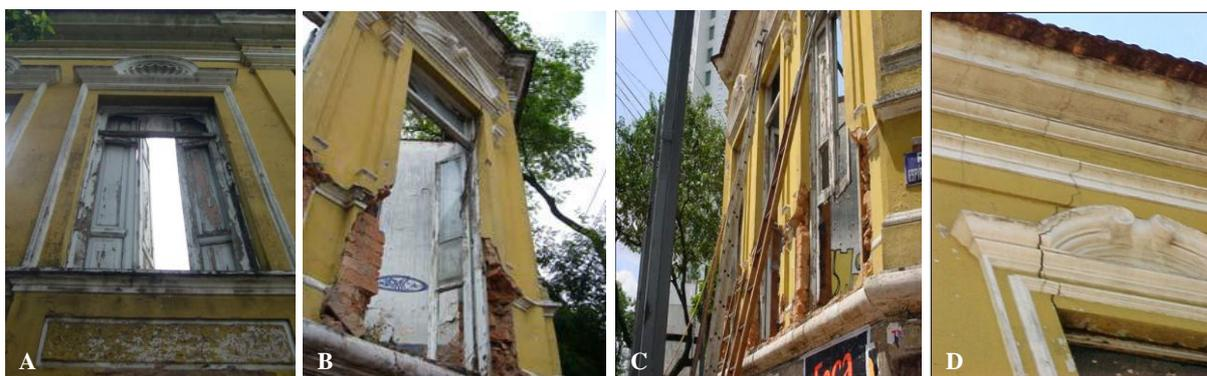
**FIGURA 32:** (A) detalhe da janela da fachada voltada para Rua Espírito Santo; (B) detalhe da janela da fachada da Av. Álvares Cabral, sem o parapeito sacado em ferro batido; (C) detalhe das janelas da fachada voltada para Av. Álvares Cabral, sem os parapeitos sacados; (D) detalhe da cimalha e adornos.
