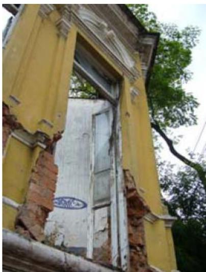
**FIGURA 24: Alvenaria em tijolo cerâmico, cimalthas e demais ornatos.**
