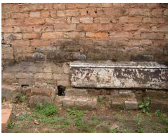
**FIGURA 30: Detalhe alvenaria sem reboco. O piso, em madeira, foi queimado pelo fogo em 2000.**
