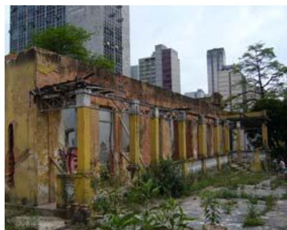
**FIGURA 31: Varanda lateral sem a cobertura.**
