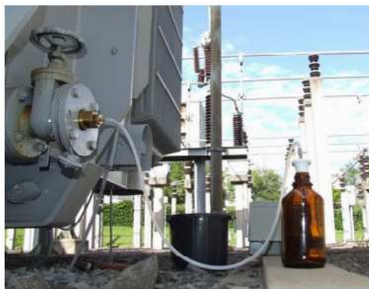
Figura 10: Coleta de óleo mineral para análise. Fonte: [30]
