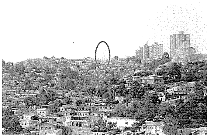
Figura a.6 – Invasão da faixa de servidão de linhas de transmissão de 138 kV em Belo Horizonte.
