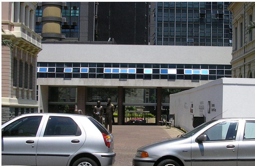
Figura 37 – vista longínqua da passarela
