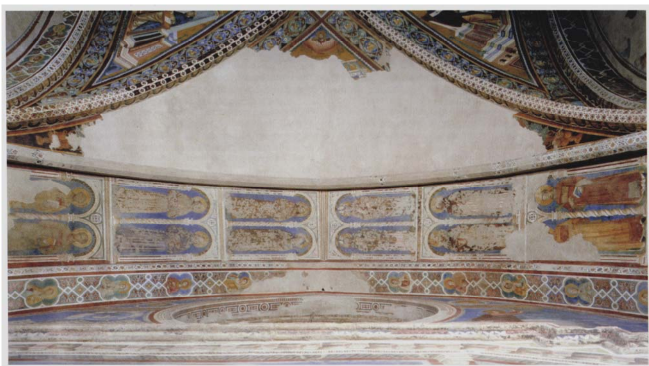
Fig.29 - Parte da parede recomposta Igreja São Francisco de Assis Fonte: Boletim Dall'utopia alla realtà , n. 3, p. 13
