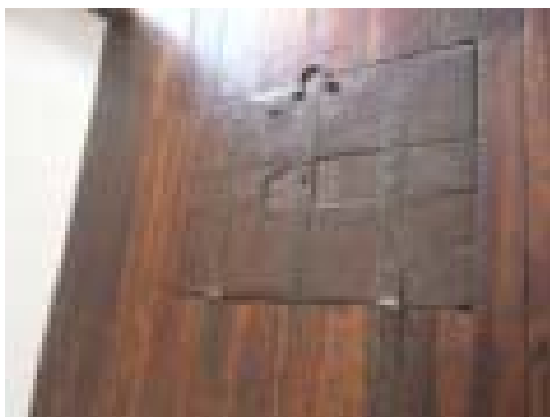
Figura 38 – Alçapão no piso da sala Vintém de Cobre, no segundo piso da edificação, que dava acesso à enxovia 2. Foto: Kleumanery Melo
