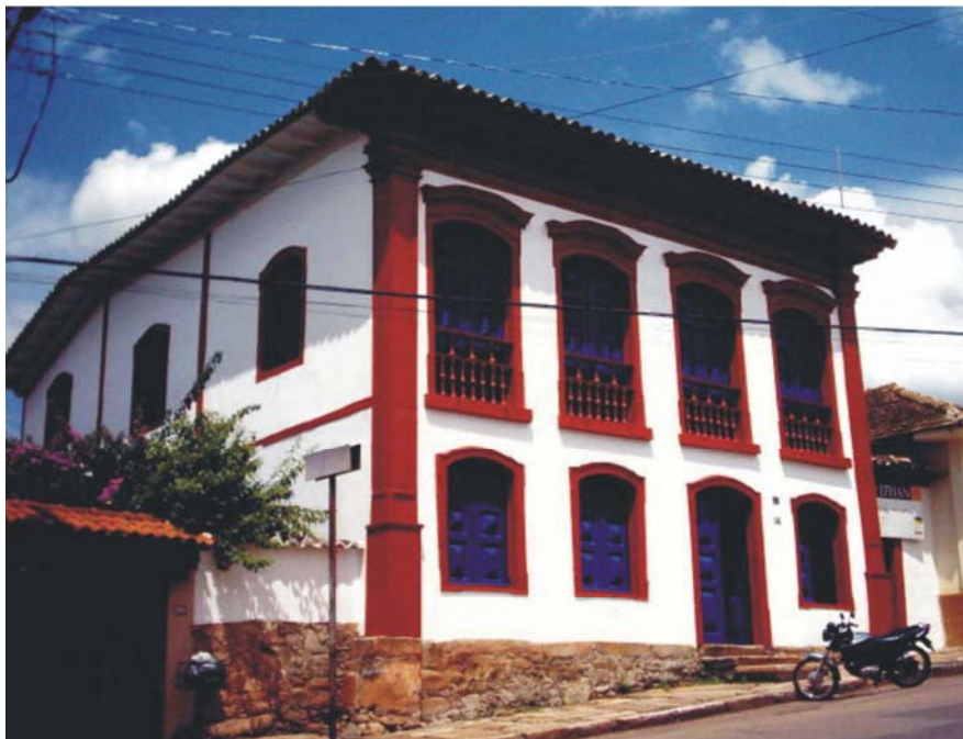
FIGURA 21 – Edificação que abriga o Museu Regional de Caeté Fonte: (BARBOZA, 2007)
