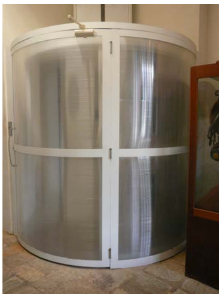
Figura 43 – Elevador destinado ao transporte de pessoas com dificuldades locomotoras Foto: Kleumanery Melo
