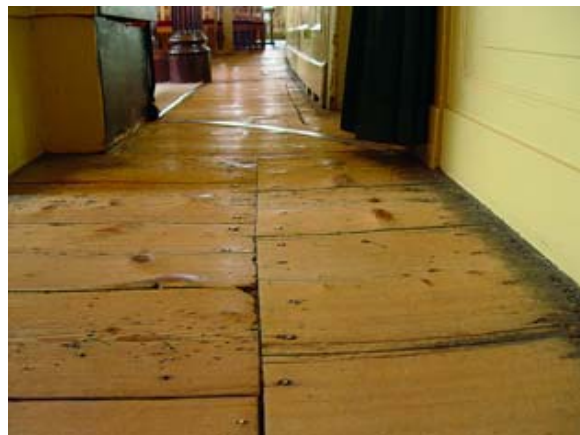
FIGURA 17- Foto do piso do andar superior do prédio FONTE: BROKERHOF (2005)
