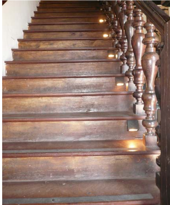
Figura 66 – Iluminação guia na escada de acesso ao andar superior do museu. Foto: Kleumanery Melo
