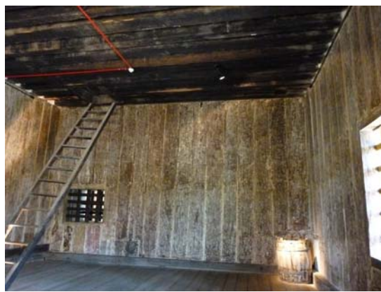
Figura 39 – Escada em madeira que dava acesso à enxovia 1. Foto: Kleumanery Melo
