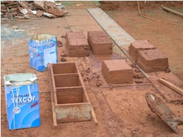
FIGURA 7 - Fabricação de tijolos de adobe. Coromandel – MG. Fonte: autor (2008).
