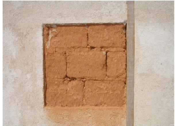
FIGURA 8 - Parede de adobe – protótipo executado pela FAOP em Ouro Preto. Fonte: autor (2008).
