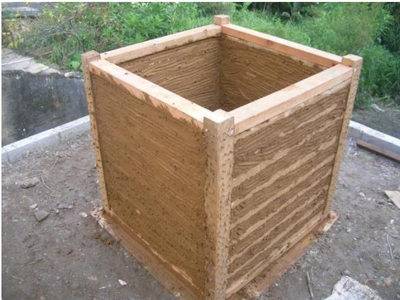
FIGURA 32 - Finalização do barreamento. Fonte: autor (2009).
