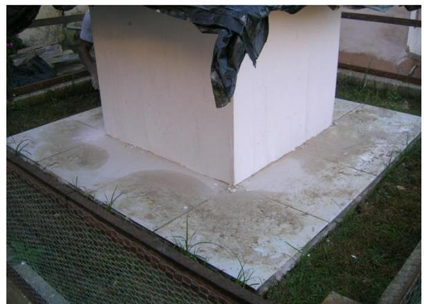
FIGURA 35 - Nivelamento com pasta de cal. Fonte: autor (2009).
