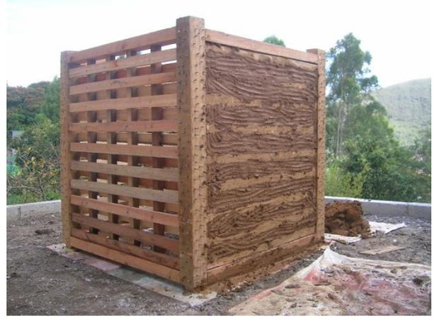
FIGURA 31 - Barreamento da estrutura.
