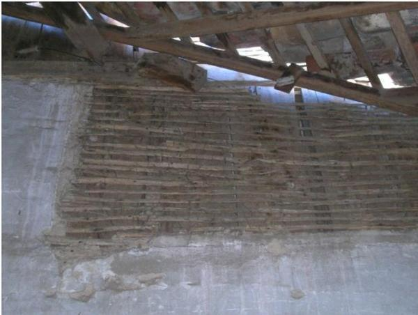
FIGURA 1 - Parede divisória de tabique. Residência em Ouro Preto. Fonte: autor (2009)
