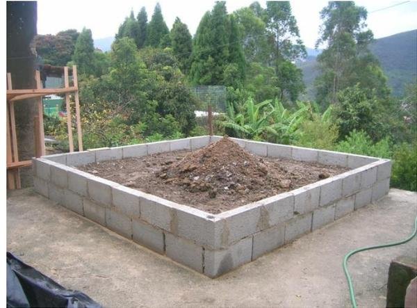
FIGURA 25- Tanque de bloco com terra compactada.
