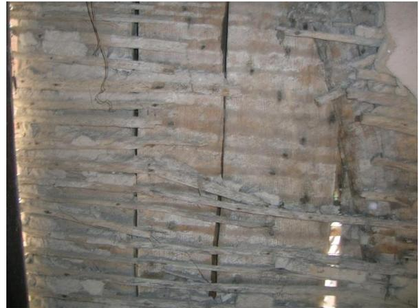
FIGURA 2 - Tabique- detalhe. Residência em Ouro Preto. Fonte: autor (2009)
