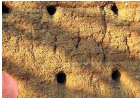
FIGURA 10 - Taipa de pilão - detalhe. Capela do Morumbi – SP. Fonte: autor (2008).
