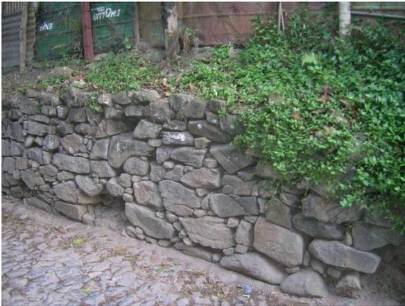
FIGURA 3 - Muro de pedra seca. Cachoeira do Campo, Ouro Preto. Fonte: autor (2009).
