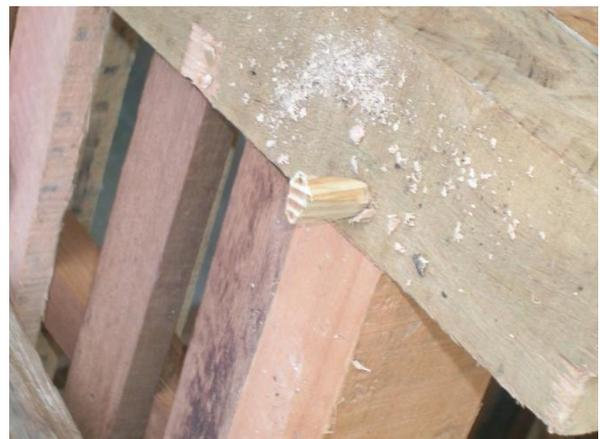
FIGURA 29 - Encaixe com pino de madeira.
