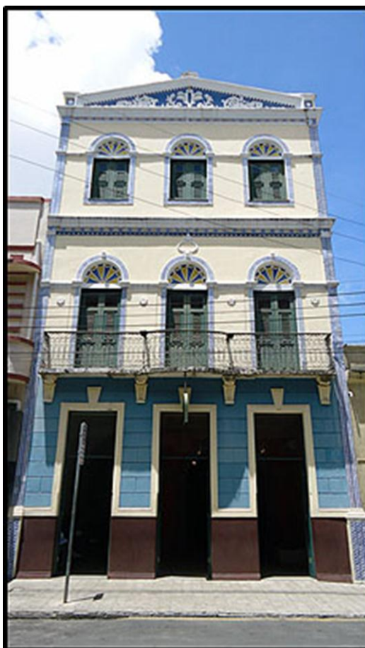
FIGURA 37. Fachada do Sobrado José Lourenço . (meados do século XIX).
