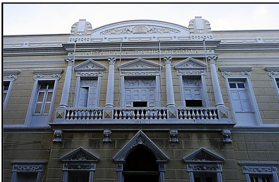
FIGURA 39. Fachada central superior da Santa Casa de Misericórdia. (1857).
