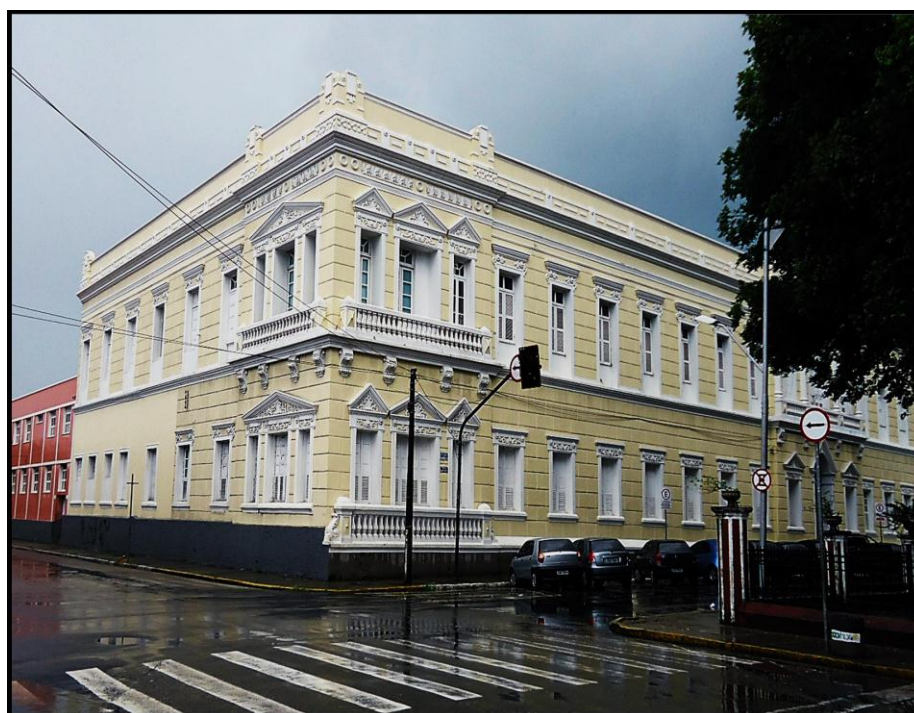
FIGURA 40. Ângulo sudeste da Santa Casa de Misericórdia. (1857).
