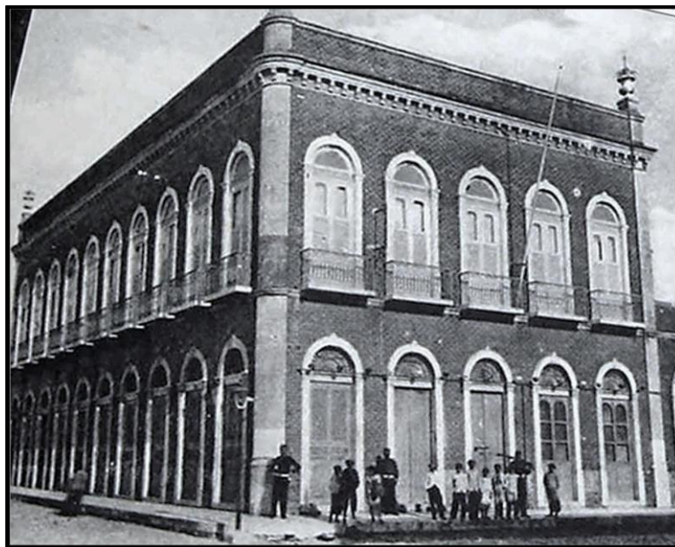
FIGURA 8. Prédio da Delegacia Fiscal (1880), atual Arquivo Público. (Foto reprodução, processada digitalmente). Fonte: Álbum de Vistas do Ceará, 1908, não paginado.
