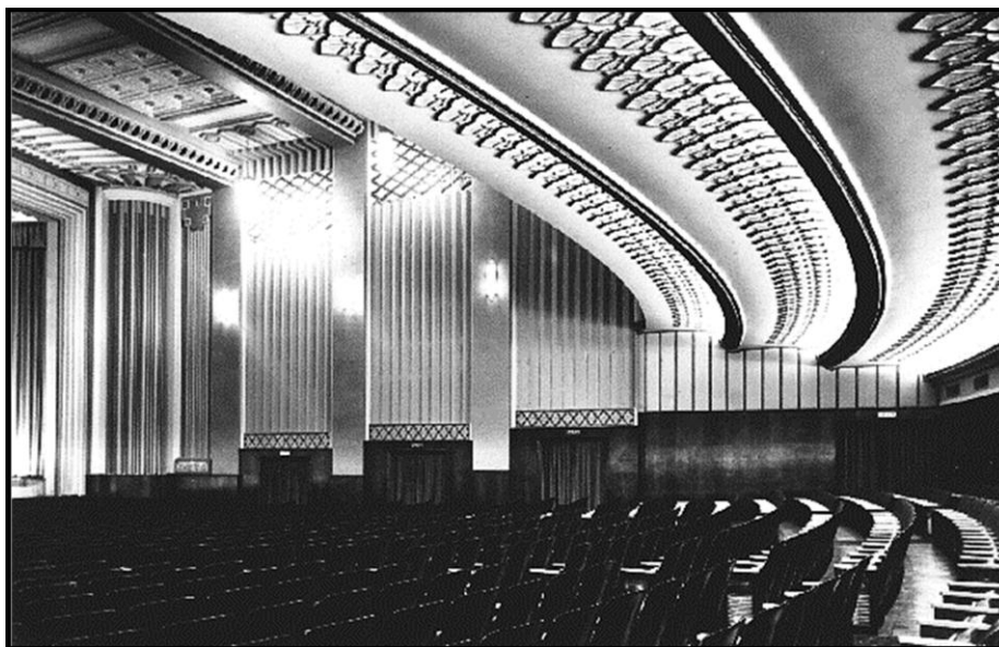
FIGURA 49. Sala de projeção do Cine São Luiz , 1958. (Acervo do Museu da Imagem e do Som). Tratamento digital da imagem. Fonte: Cineceara2010, online .
