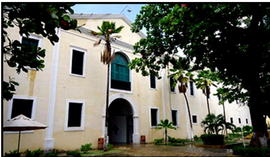
FIGURA 34. Fachada do espaço principal da Antiga Cadeia Pública. (1866).
