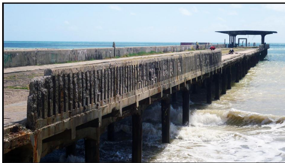
FIGURA 66. Ponte Metálica , construção iniciada no início do século XX.
