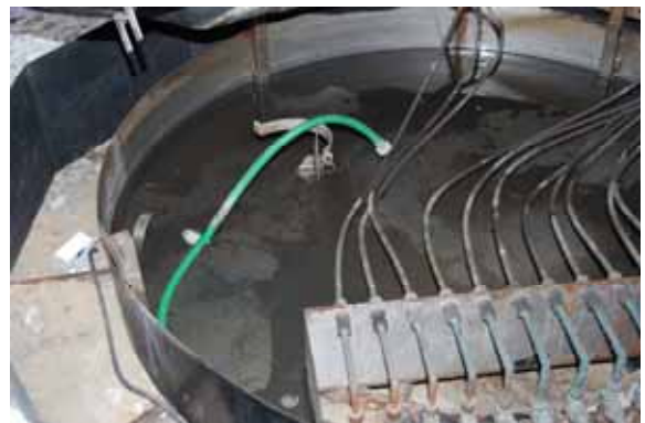
FIGURA 79- Acúmulo de sais na parte inferior da peça e acúmulo de sujidades nas mangueiras de borracha e no fundo do reservatório. Foto da autora, 2011.
